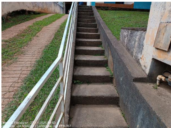
escada de acesso
