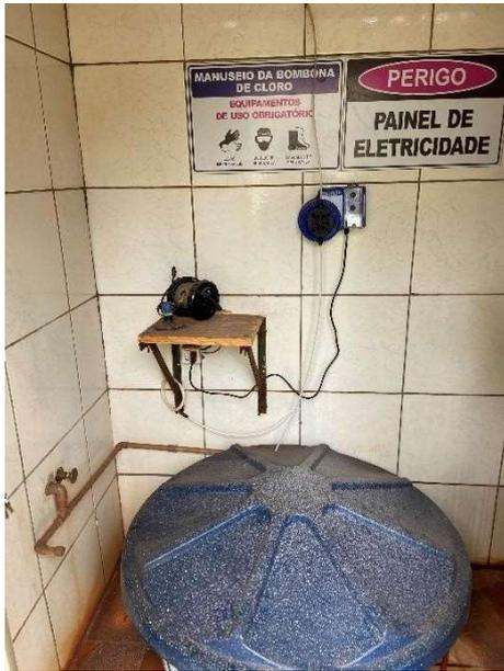
Foto 29 – Poço, tampa do poço, laje com comprimento de 100 cm, espessura acima de 15 cm e leve declividade.
