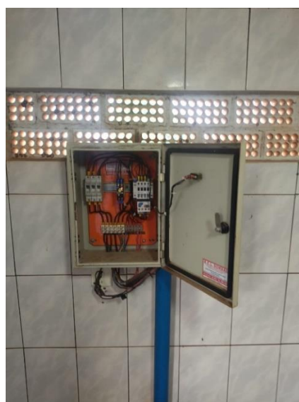
Foto 40: Ausencia de diagrama unifilar.
