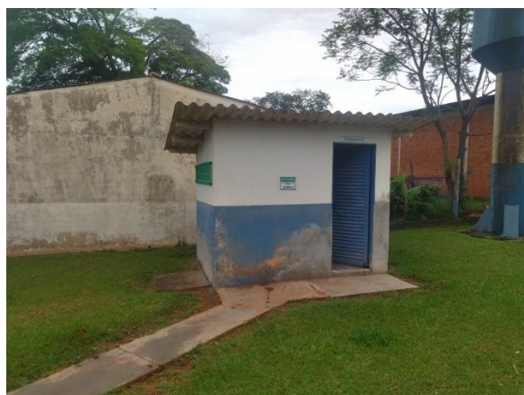
Foto 38: Casa de comando.
