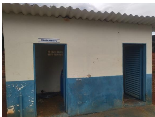
Foto 32: Abrigo do sistema de tratamento.
