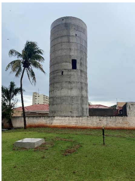
Foto: Reservatório em construção na unidade de tratamento.
