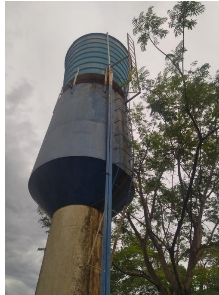
Foto 72: Escadas inadequadas e falta de proteção nas tampas superiores de inspeção . Foto 73: Ausencia de guarda-corpo.
