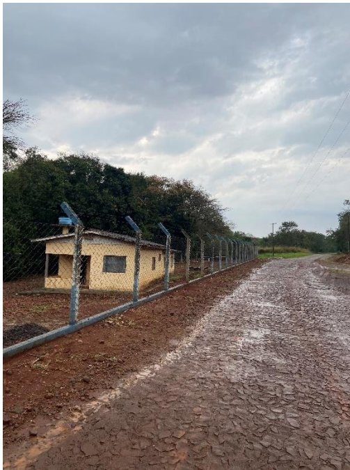
Foto 58: Cercamento mina 01 Sede.
