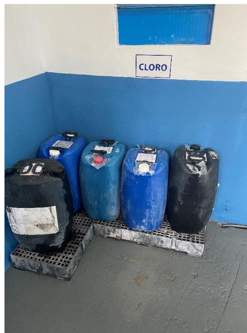
Foto 13: Armazenamento de produtos químicos.
