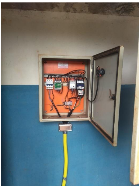
Foto 22: Ausencia de diagrama unifilar.
