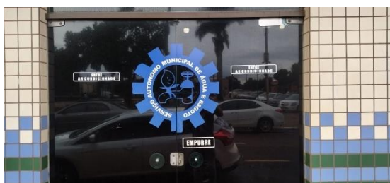
Foto 01: Falta de exposição de horários de atendimento.
