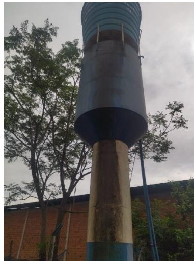
Foto 71: Vazamentos aparentes.
