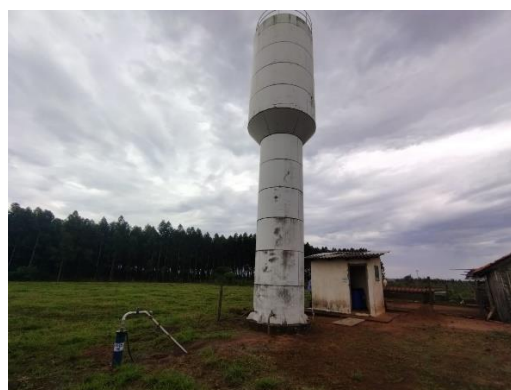
Foto 76: Vista geral reservatório.
