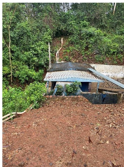
Foto 54: Estrutura da mina.
