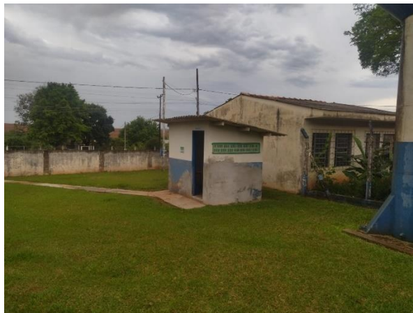
Foto 49: Abrigo do sistema de tratamento de água (Poço 05).
