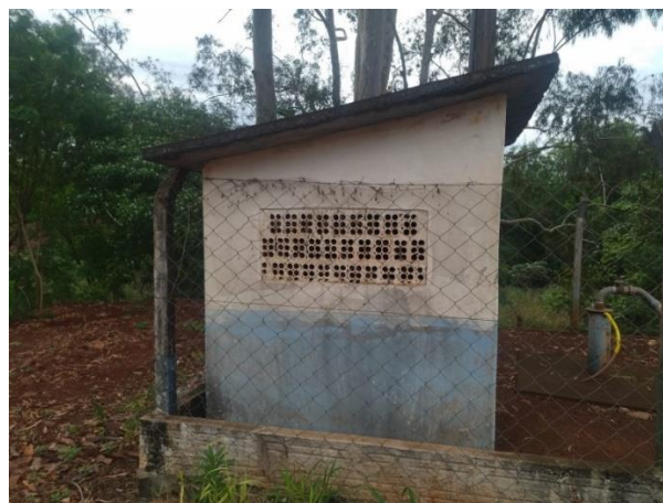
Foto 27: Casa de comando, poço 03 e 04.
