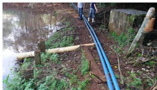
Extravasor de água sem tela de proteção.
