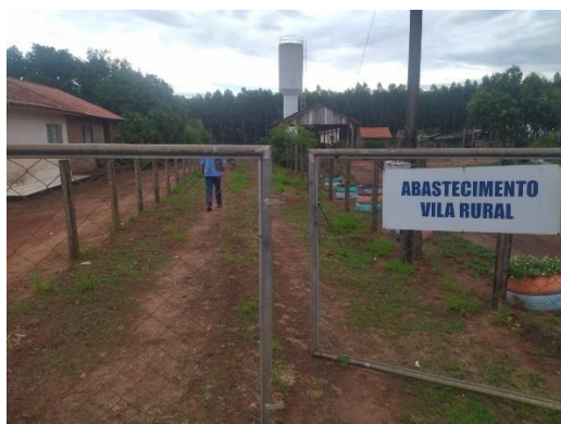
Foto 75: Ausência de identificação específica do reservatório.
