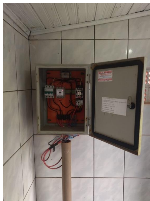
Foto 31: Falta de diagrama unifilar.
