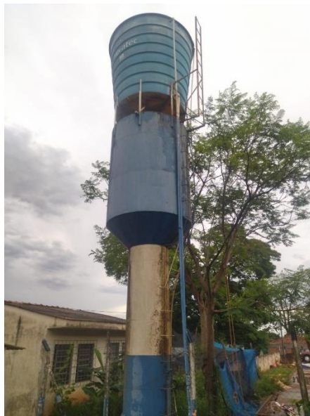
Foto 72: Escadas inadequadas e falta de proteção nas tampas superiores de inspeção . Foto 73: Ausencia de guarda-corpo.
