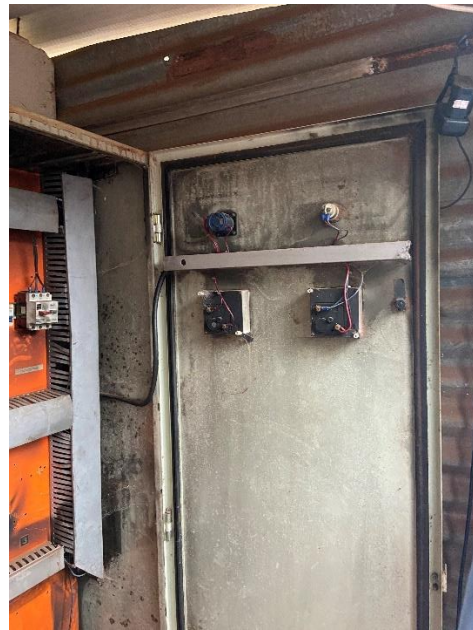
Foto 57: Ausencia de diagrama unifilar.
