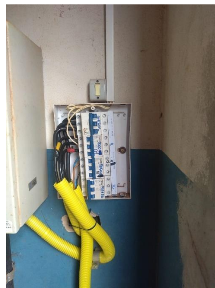
Foto 26: Falta de diagrama unifilar.
