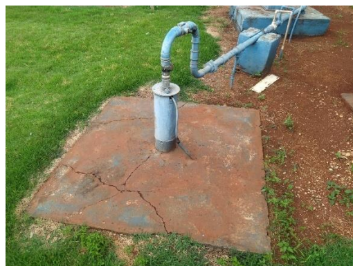
Foto 29: Instalações do poço.
