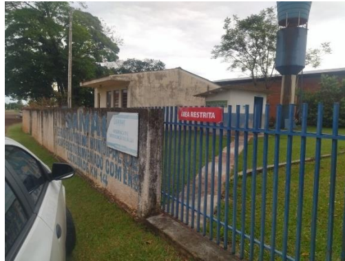
Foto 70: Falta de identificação específica para o reservatório.
