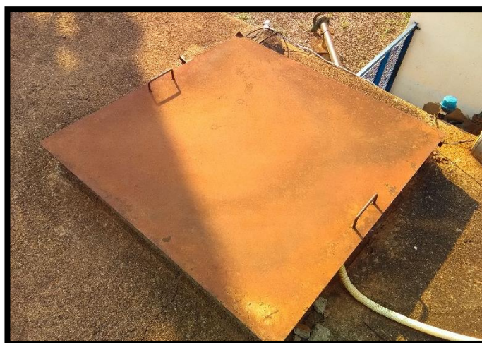
Imagem 32: Abertura de inspeção do Reservatório apoiado junto ao Poço 2
