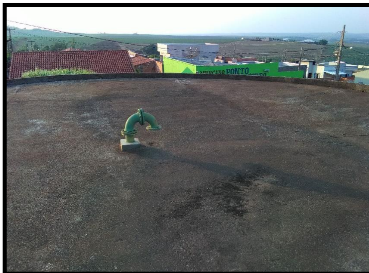
Imagem 37: Cobertura do Reservatório Apoiado junto ao Poço 3
