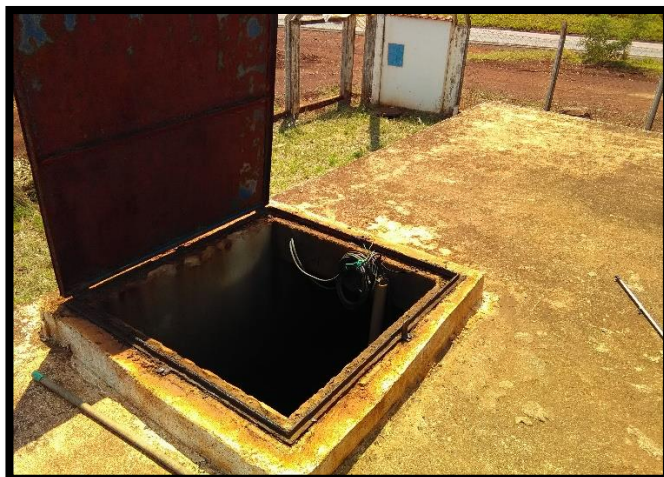
Imagem 40: Abertura de inspeção do Reservatório Apoiado - Crispi
