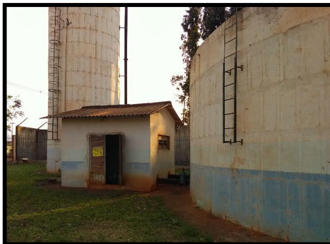
Imagem 34: Reservatórios Apoiado e Elevado junto ao Poço 4
