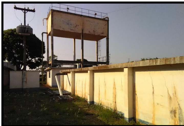
Imagem 31: Reservatórios apoiado e elevado junto ao Poço 2
