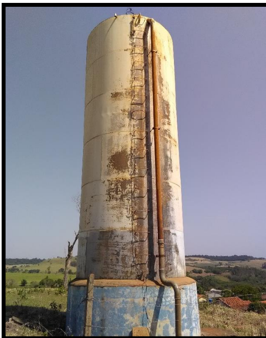
Imagem 43: Reservatório Elevado do distrito
