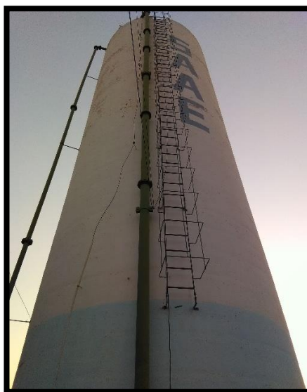
Imagem 38: Reservatório Elevado junto ao Poço 5
