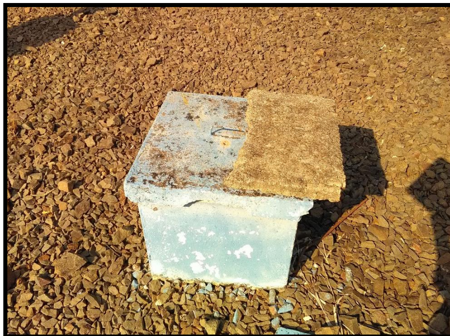
Imagem 28: Abertura de inspeção do Reservatório Enterrado
