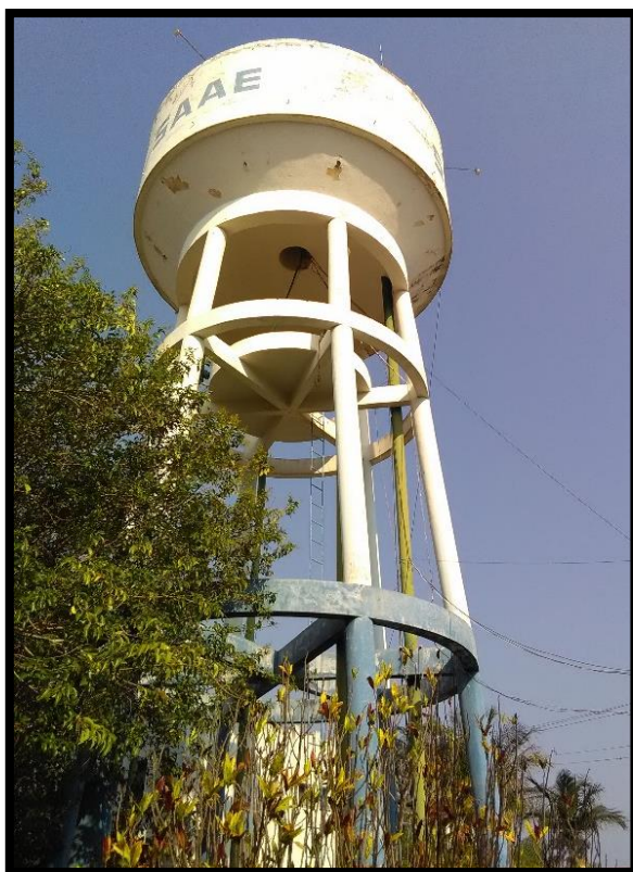
Imagem 29: Reservatório elevado da Sede
