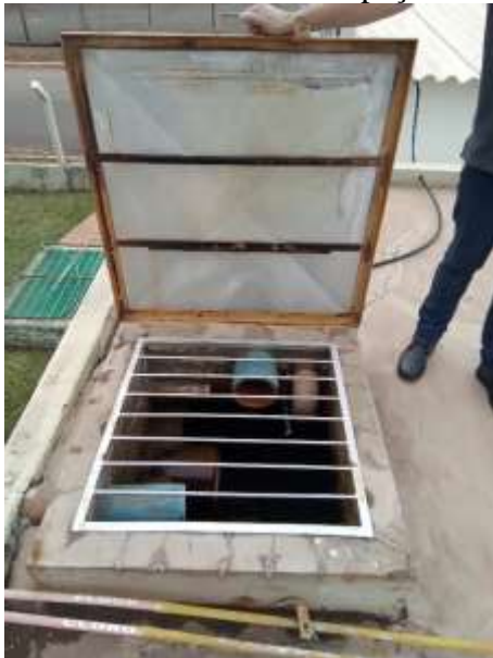
Foto 62 – Abertura de inspeção RAP 01 sede
