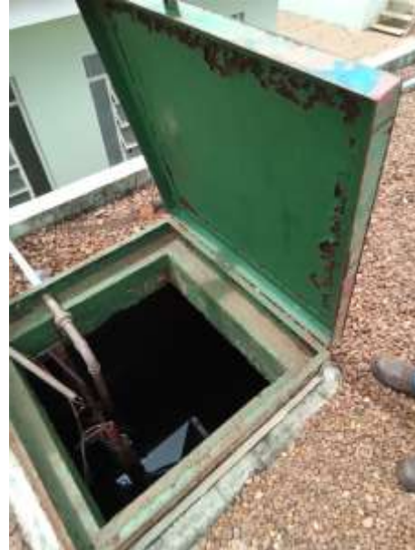
Foto 73 – Abertura e tampa de inspeção 02 RAP 02 sede
