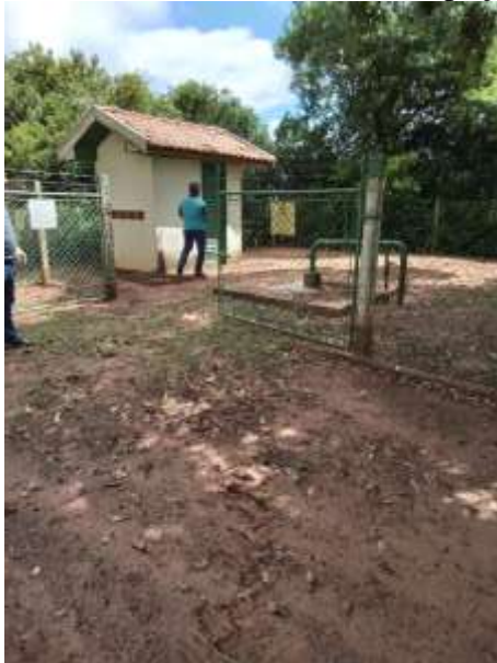
Foto 15 – Acesso e isolamento poço 7
