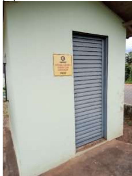
Foto 10 – Identificação casa de comando poço 8
