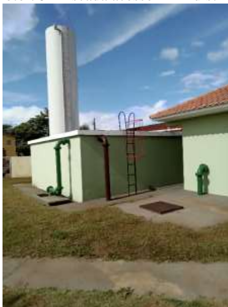
Foto 76 – Escada acesso RAP distrito
