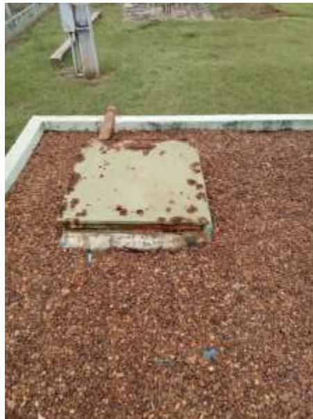
Foto 71 – Tampa 01 de abertura de inspeção RAP 02 sede
