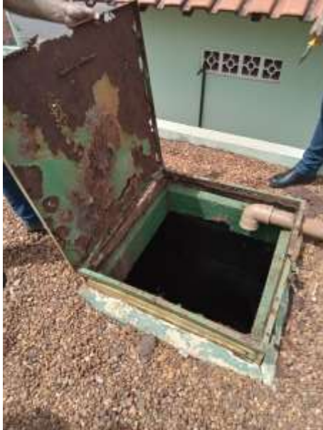
Foto 72 – Abertura 01 de inspeção RAP 02 sede
