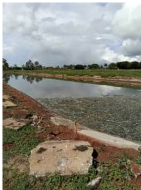
Foto 105 – Lagoa facultativa 02 (desativada no dia fiscalização para manutenção)
