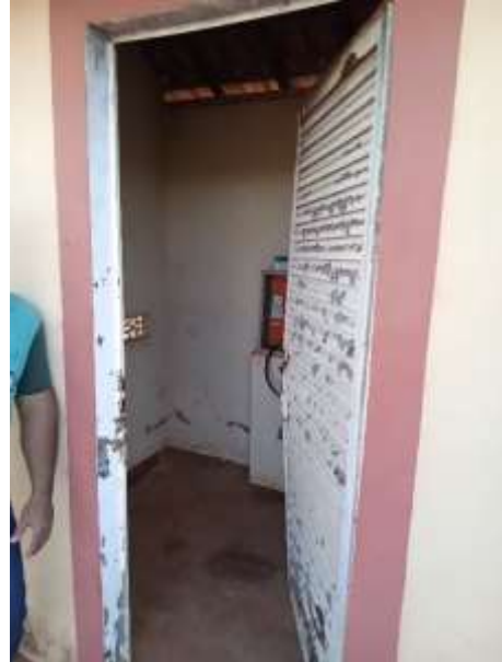
Foto 44 – Casa de comando poço 2 – distrito
