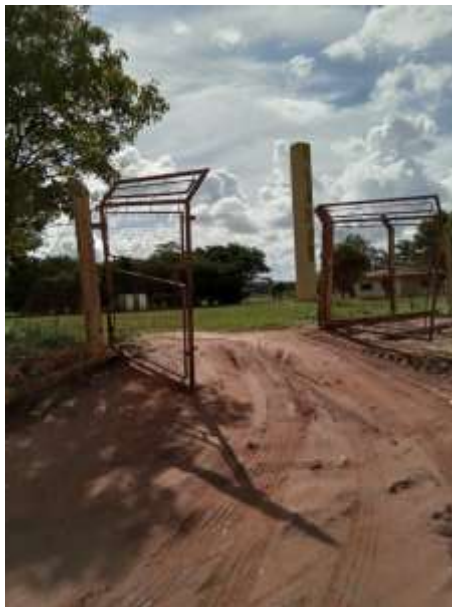
Foto 99 – Portão de acesso danificado
