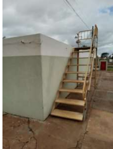
Foto 61 – Acesso RAP 01 sede
