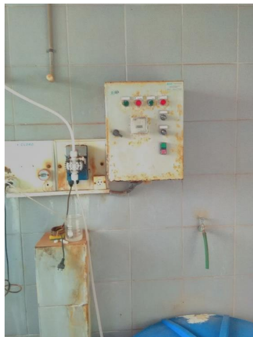
Foto 62 – Frente do quadro de comando da dosadora (distrito)
