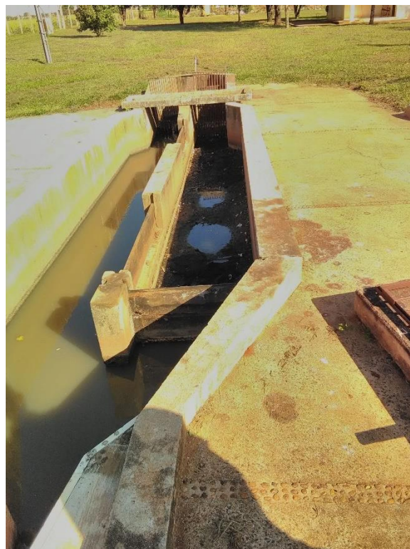
Foto 124 – Caixa de areia
