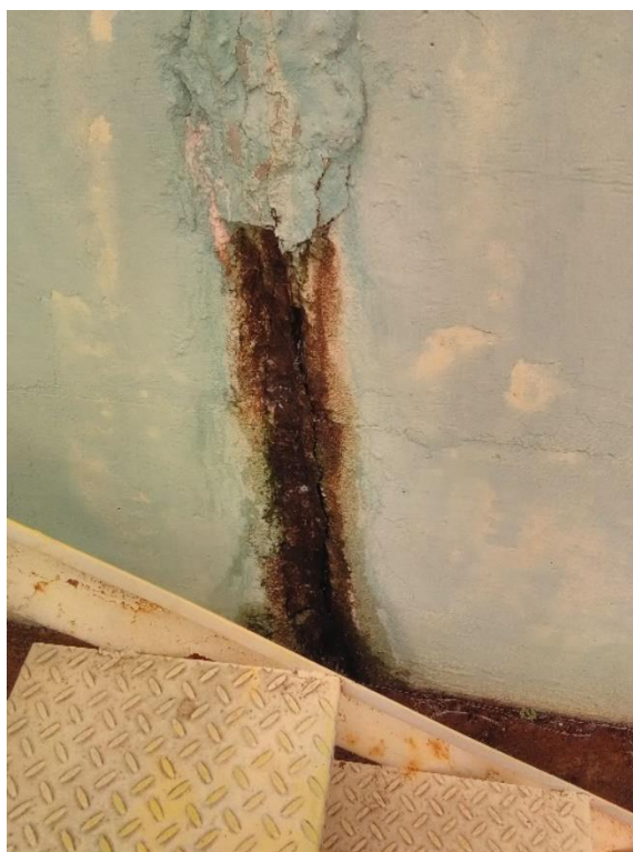
Foto 74 – Detalhe vazamento RAP 02
