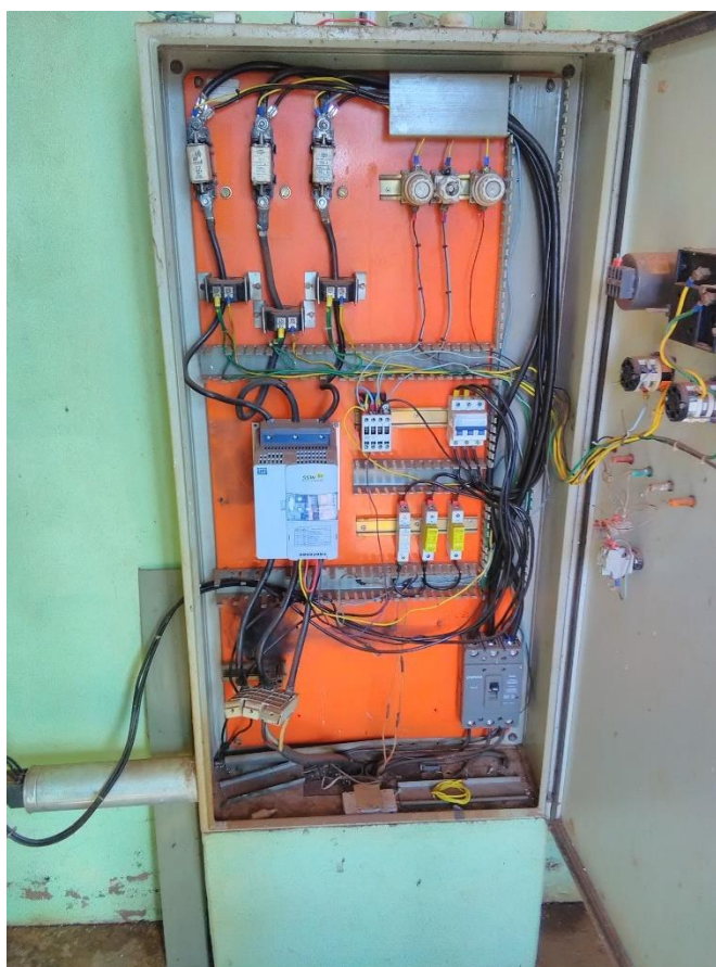
Foto 16 – Quadro de comando poço 01
