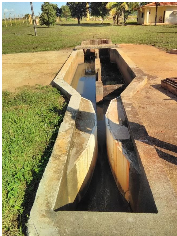
Foto 123 – Calha Parshall (entrada)
