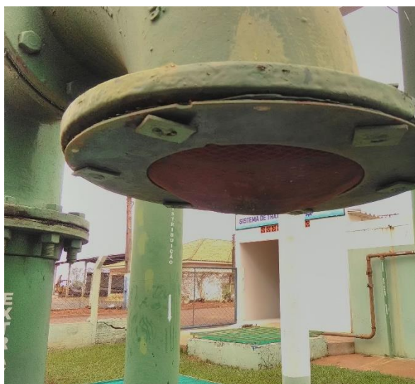
Foto 68 – Extravasador REL (detalhe)
