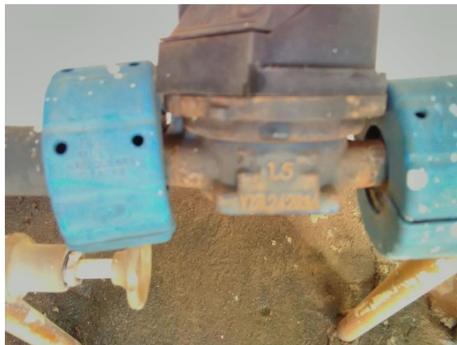
Foto 103 – Medição pressão na rede Rua Antonio Pegussi nº. 6 ((Latitude: -22.721043°, Longitude: -52.610949°) – P = 30 mca
