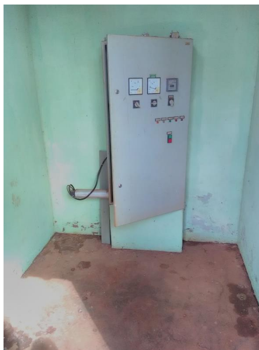
Foto 16 – Quadro de comando poço 01
