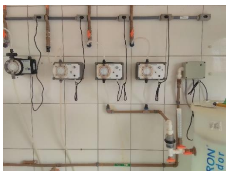
Foto 53 – Dosadoras de cloro e flúor (foto 02) - sede
