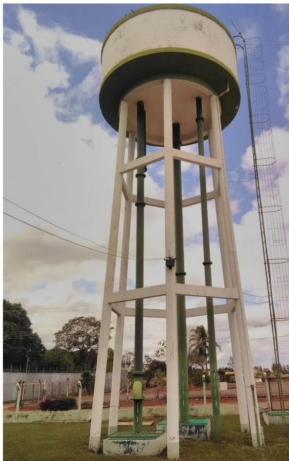
Foto 68 – Extravasador REL (detalhe)
