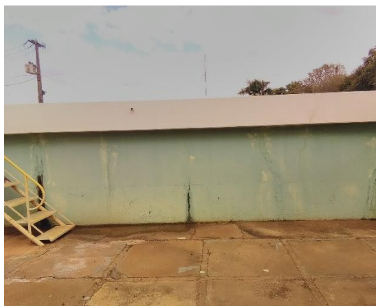
Foto 72 – Reservatório apoiado 02 Foto 73 – Reservatório apoiado (lateral) (acesso)
