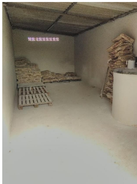
Foto 58 – Depósito dos materiais utilizados no tratamento (sede)
