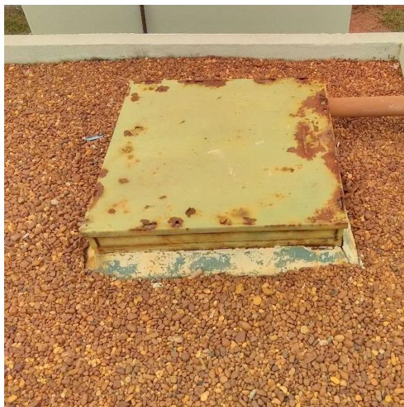
Foto 75 – Tampa de acesso RAP 02
