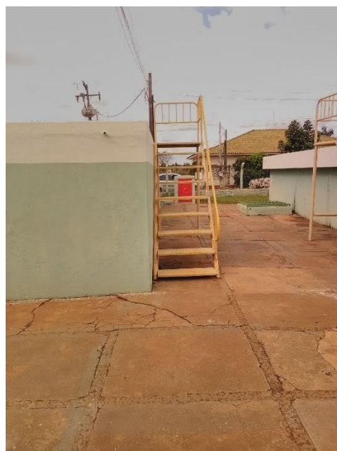
Foto 69 – Escada de acesso RAP 01
