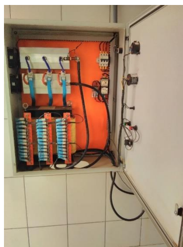
Foto 56 – Quadro de comando da unidade de tratamento (sede)
