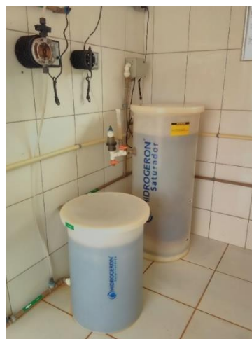
Foto 54 – Bombas dosadoras de cloro e flúor (foto 03) - sede
