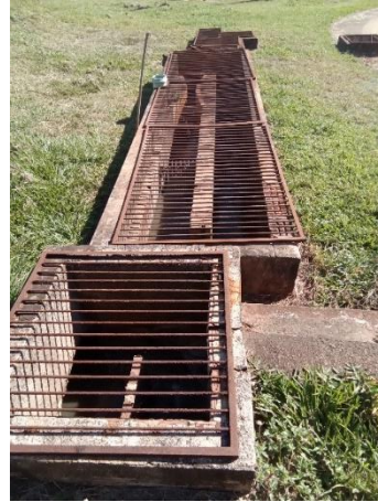
Foto 67 – Caixa de areia e gradeamento
