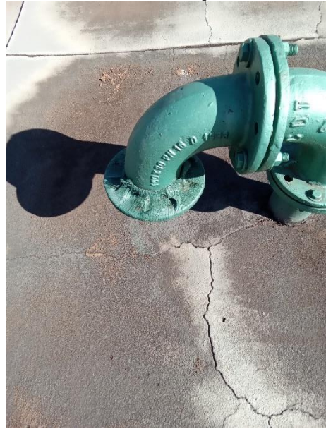
Foto 50 – Sistema de ventilação RAP sede
