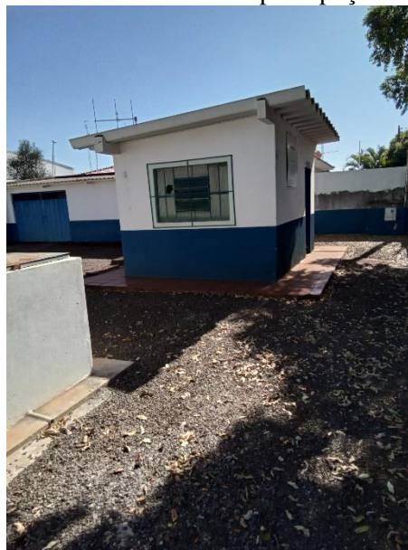
Foto 32 – Casa de comando e pátio poço 1
