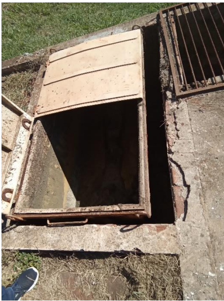
Foto 68 – Local de despejo de materiais retirados do gradeamento e caixa de areia
