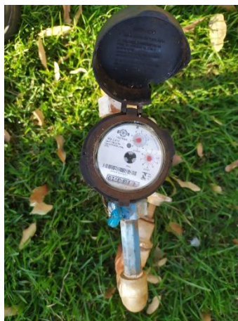
Foto 55 – Hidrômetro P02 – P = 33,50 mca
