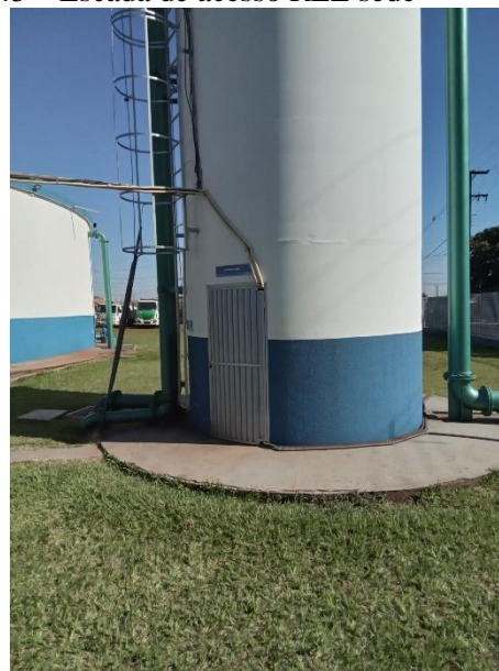
Foto 45 – Escada de acesso REL sede
