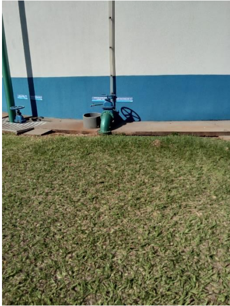
Foto 49 – Controle de nível e tomada de água para análises
