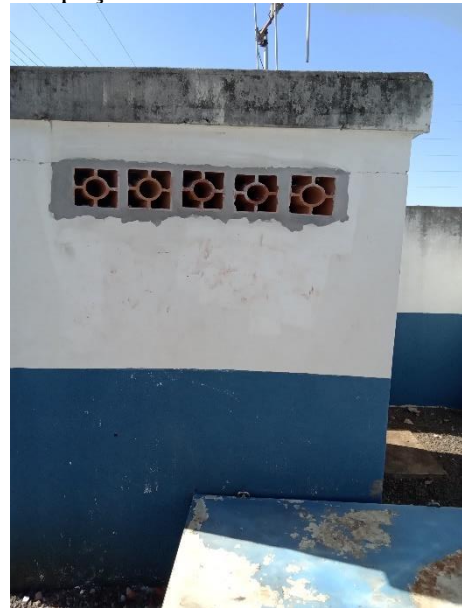
Foto 28 – Sem tela mosquiteira casa de comando poço 3
