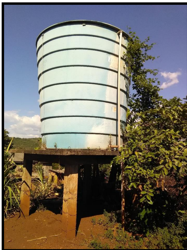
Imagem 19: Reservatório apoiado de 300 m³
