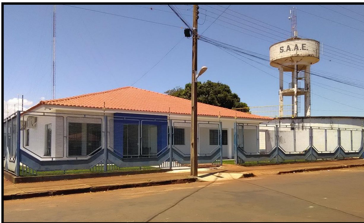
Imagem 1: Fachada da área comercial e administrativa
