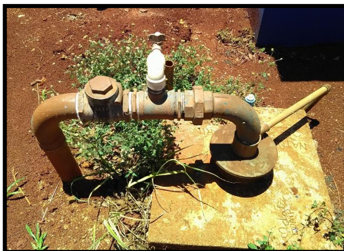
Imagem 11: poço Parque industrial
