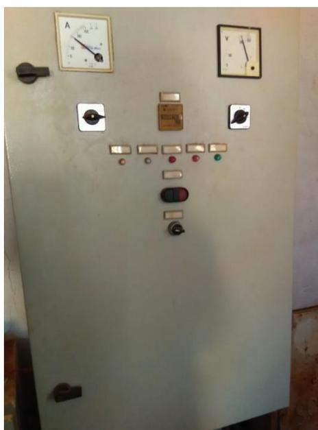
Foto 30 – Quadro de comando poço Caixa Velha
