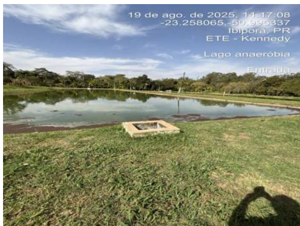
Lagoa anaeróbia, manchas comuns na superfície.
