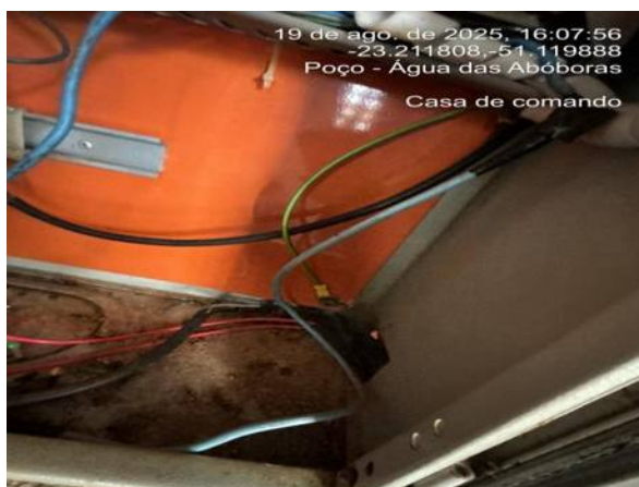
Aterramento do quadro de comando. (A parte inferior do quadro e os cabos estão visivelmente sujos, com acúmulo de poeira e talvez umidade/ferrugem)
