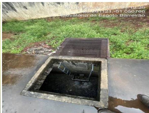
Acesso manutenção gradeamento.
