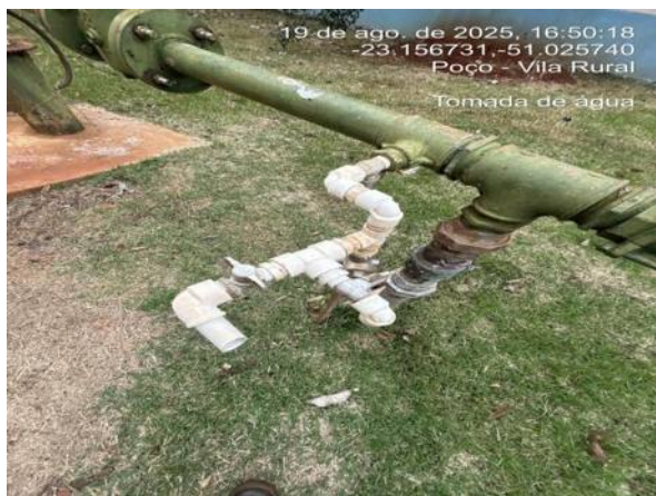
Tomada para coleta de água bruta.
