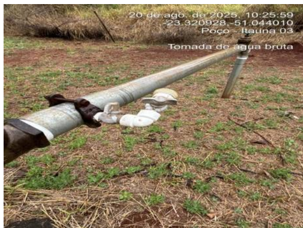
Tomada de coleta de água bruta.
