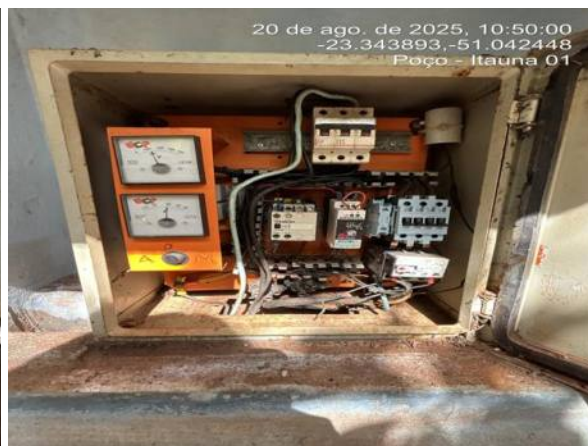
Estrutura interna quadro de comando.
