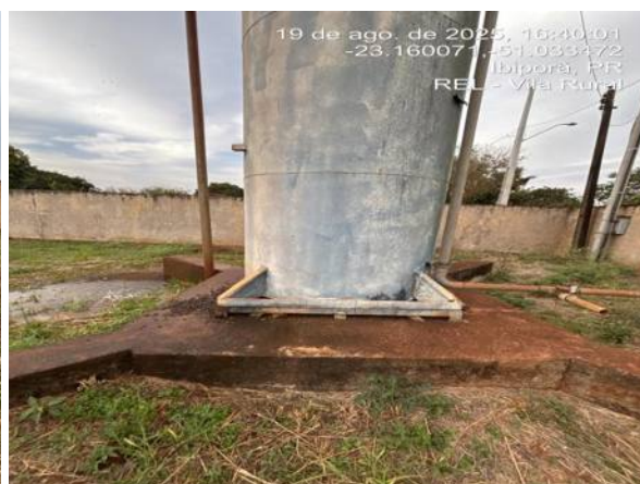
Estrutura do reservatório, sem vazamentos aparentes.
