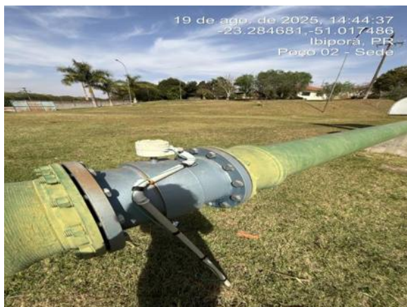
Sensor de medição no cavalete.
