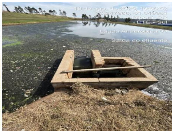
Dispositivo da saída da lagoa anaeróbica 03.
