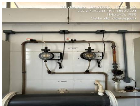
Dosadoras automáticas instaladas.
