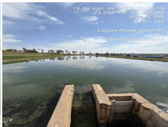
Dispositivo da saída da lagoa anaeróbia 02.
