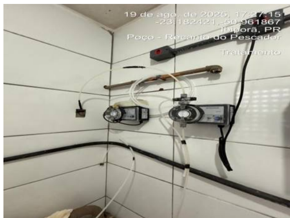
Dosadoras automáticas instaladas.
