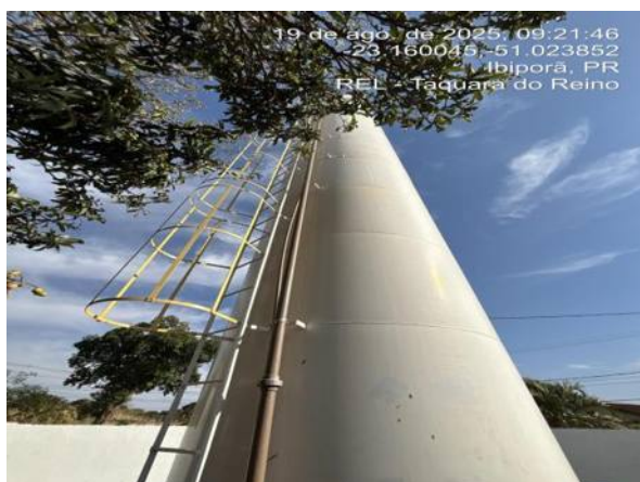
Estrutura do reservatório, sem sinais de vazamento.
