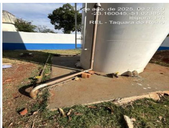
Estrutura do reservatório, sem sinais de vazamento.
