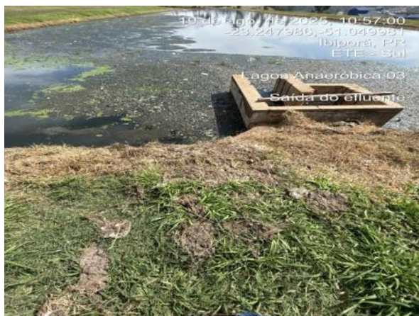
Dispositivo da saída da lagoa anaeróbica 03.
