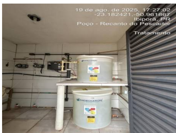
Tanque de solução de hipoclorito de sódio.
