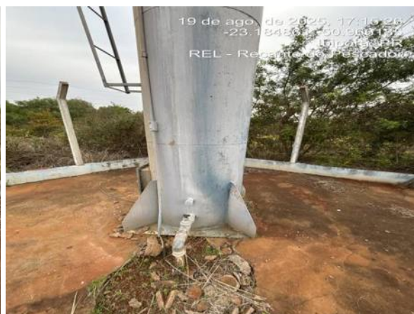
Estrutura do reservatório, sem vazamentos aparentes.
