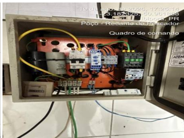
Parte interna do quadro de comando.
