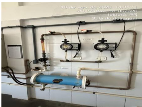
Dosadoras automáticas instaladas.
