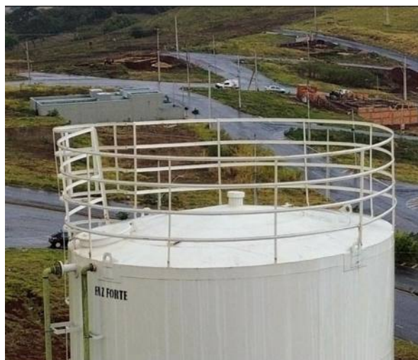
Tampa adequadamente fechada, com cadeado.
