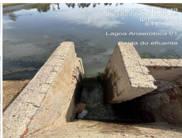
Dispositivo da saída da lagoa anaeróbia 01.
