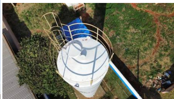
Guarda-corpo do reservatório.
