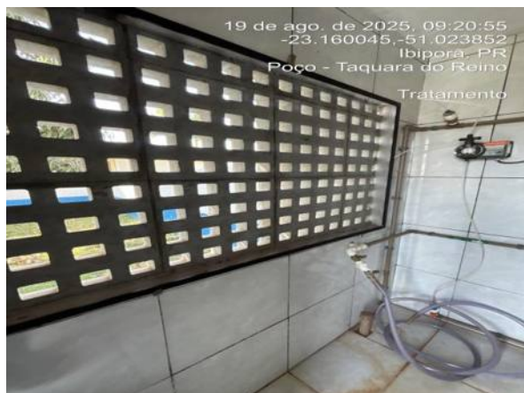
Dosadora automática instalada.
