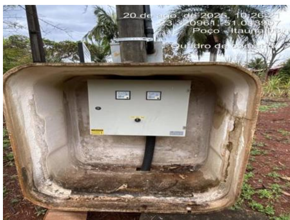
Estrutura de proteção do quadro de comando.
