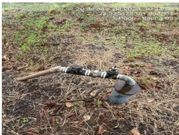
Estrutura do poço, sem macromedidor.
