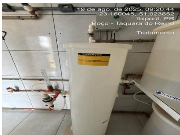
Tanque de solução de fluossilicato de sódio.
