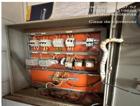
Parte interna do quadro de comando.
