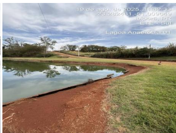
Taludes ao redor da lagoa anaeróbia 01.
