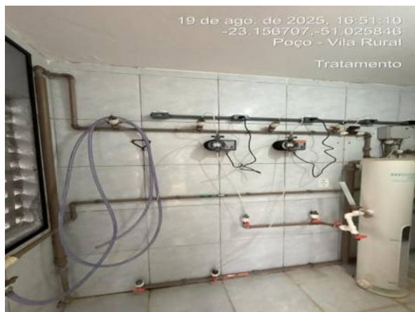
Dosadoras automáticas instaladas.
