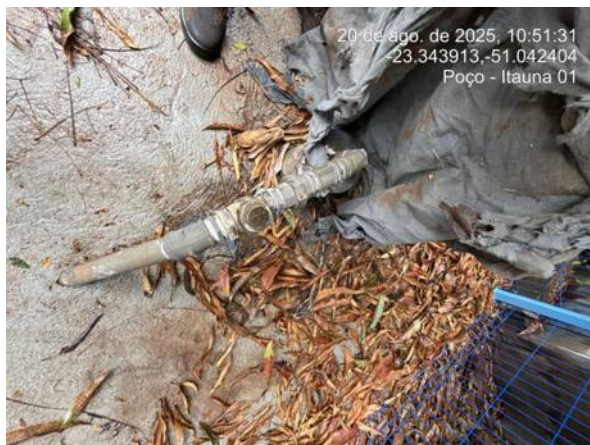
Estrutura do poço, sem macromedidor.
