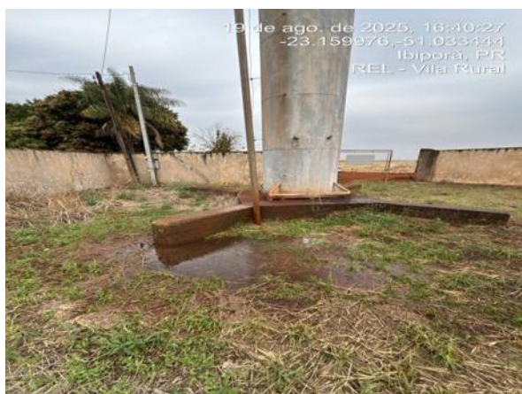
Estrutura do reservatório, sem vazamentos aparentes.
