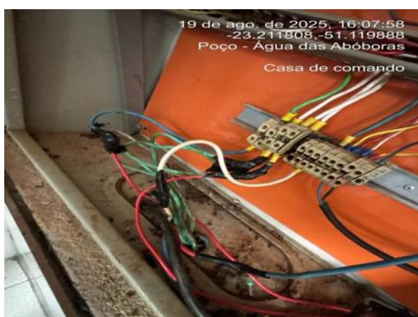
Emendas com fita isolante em vários cabos e pontas de cabos soltas ou mal conectadas.
