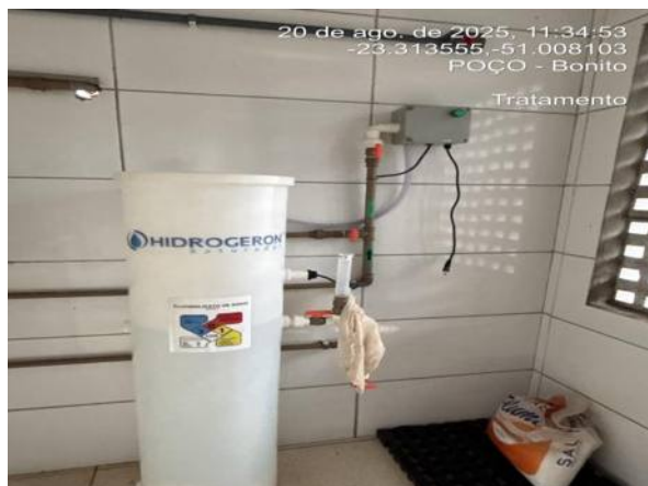
Tanque de solução de fluossilicato.
