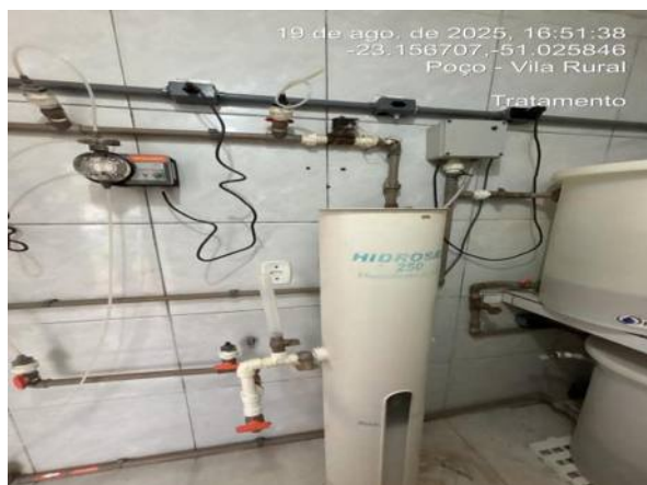
Tanque de solução de fluossilicato de sódio.
