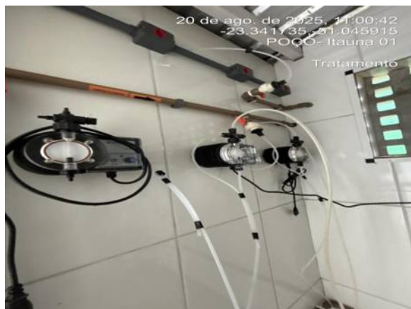
Dosadoras automáticas instaladas.
