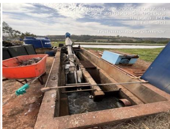
Estrutura gradeamento.
