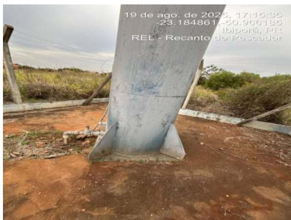
Estrutura do reservatório, sem vazamentos aparentes.
