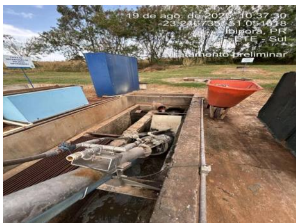
Estrutura gradeamento.
