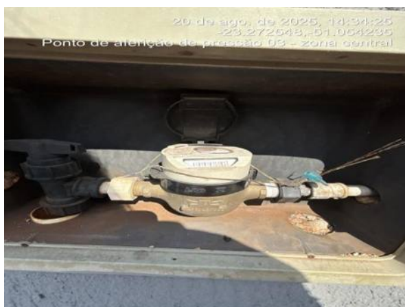
Hidrômetro no cavalete de aferição, ponto 03.
