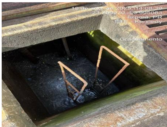
Estrutura gradeamento.
