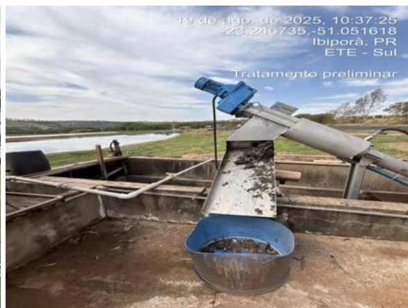
Estrutura gradeamento.
