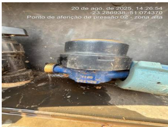
Hidrômetro no cavalete de aferição, ponto 02.
