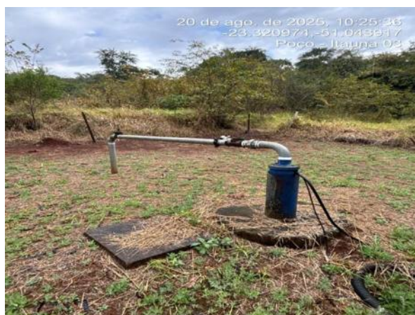
Estrutura do poço, sem macromedidor.
