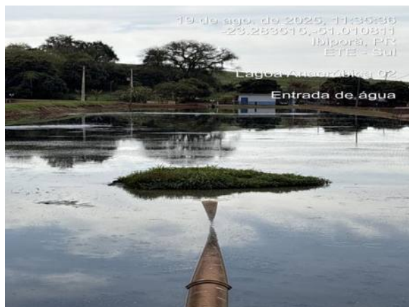
Existência de vegetação na lagoa anaeróbia.
