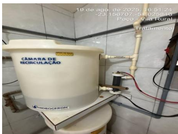
Tanque de solução de hipoclorito de sódio.
