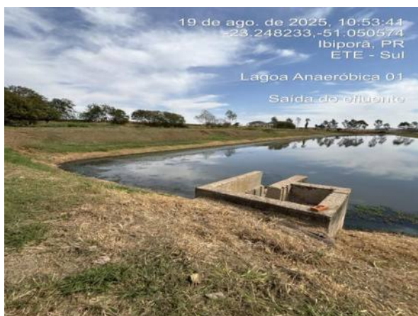
Dispositivo da saída da lagoa anaeróbia 01.
