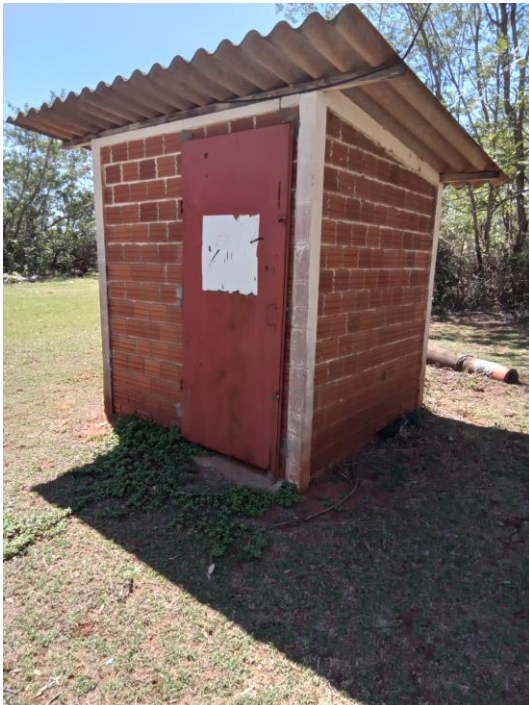
Foto 46 – Casa de comando
