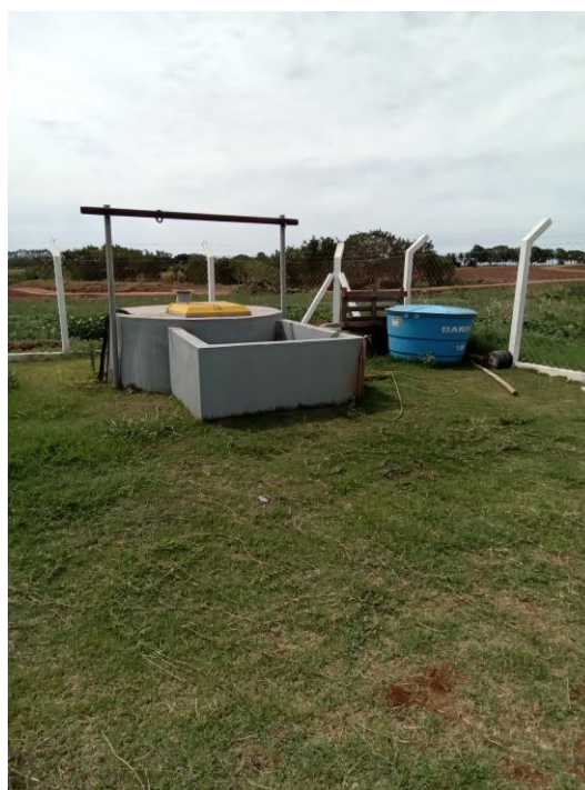
Foto 121 – Estrutura estação elevatória de esgoto
