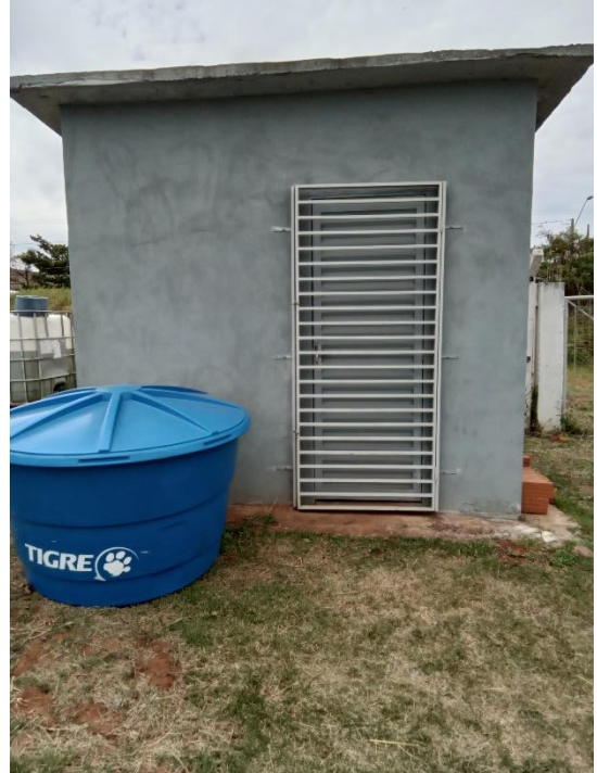
Foto 139 – Casa de comando
