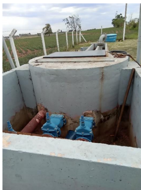
Foto 135 – Estrutura estação elevatória de esgoto
