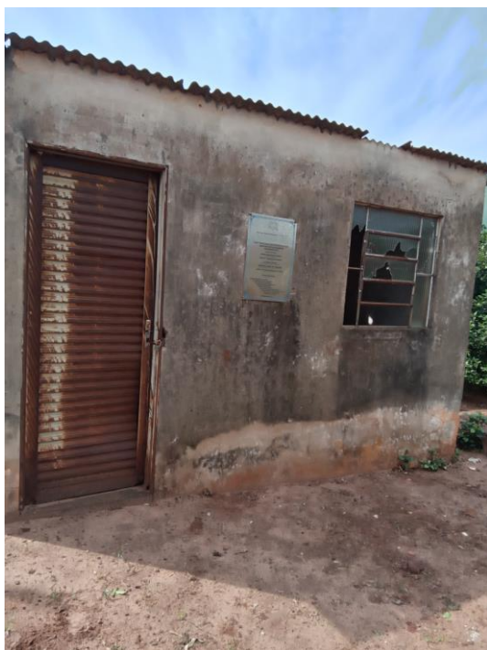
Foto 17 – Casa de comando
