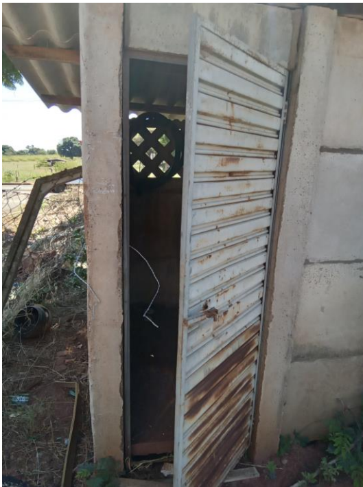
Foto 40 – Casa de comando
