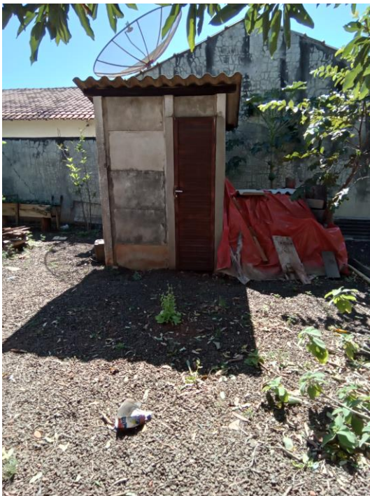
Foto 30 – Casa de comando
