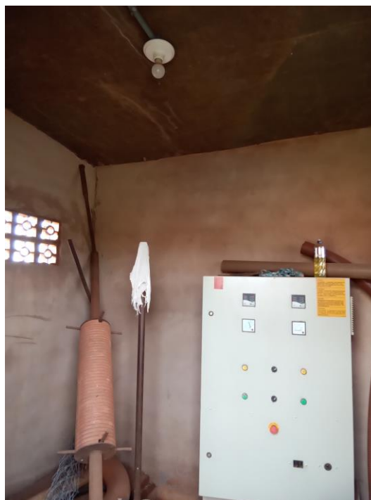
Foto 127 – Iluminação e aberturas de ventilação
