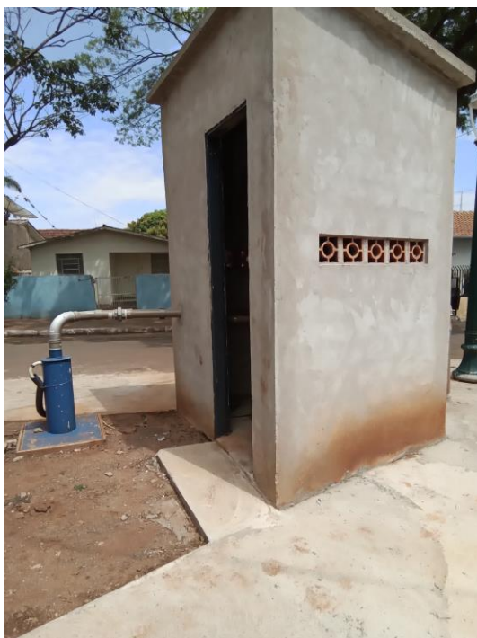
Foto 58 – Poço/ casa de comando
