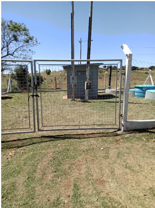
Foto 128 – Acesso elevatória de esgoto
