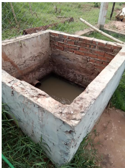
Foto 145 – Caixa receptora
