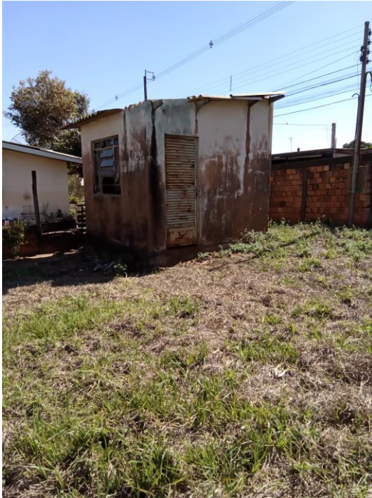
Foto 24 – Casa de comando
