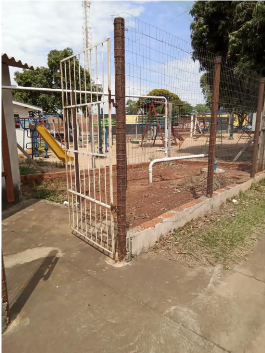
Foto 62 – Acesso ao Poço Ginásio
