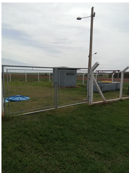
Foto 120 – Acesso elevatória de esgoto
