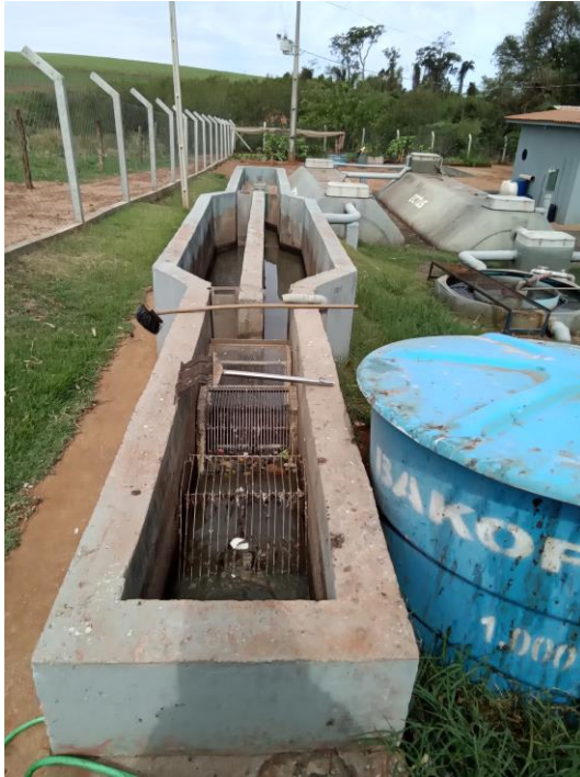
Foto 146 – Gradeamento e caixa de areia
