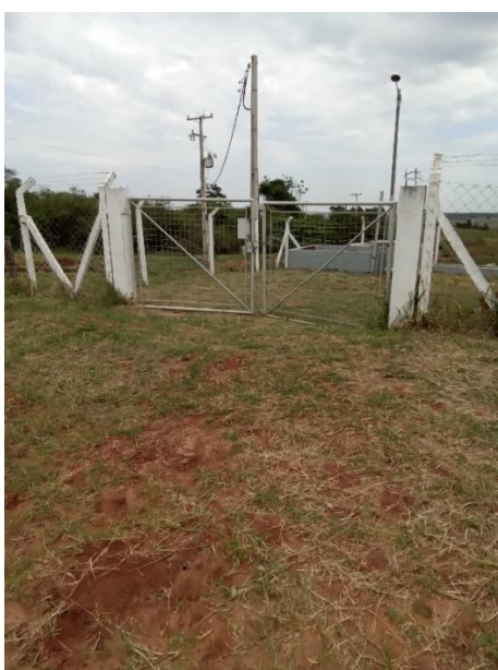
Foto 134 – Acesso elevatória de esgoto
