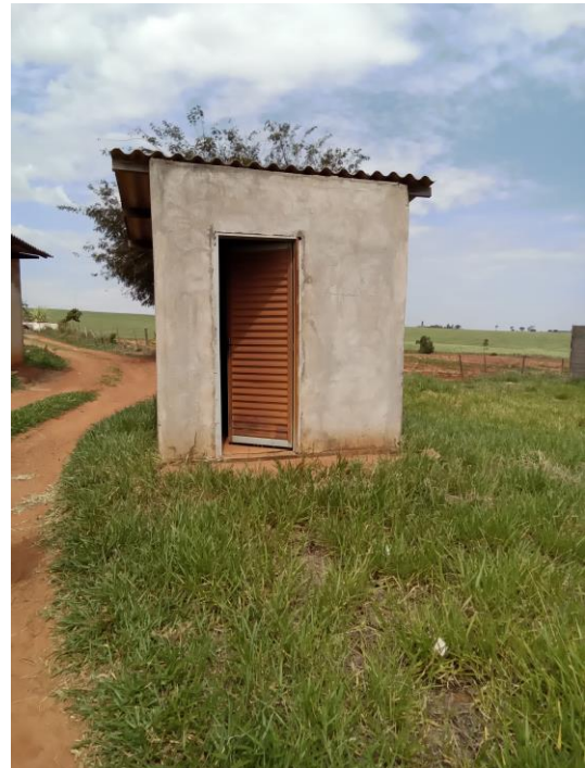
Foto 71 – Casa de comando
