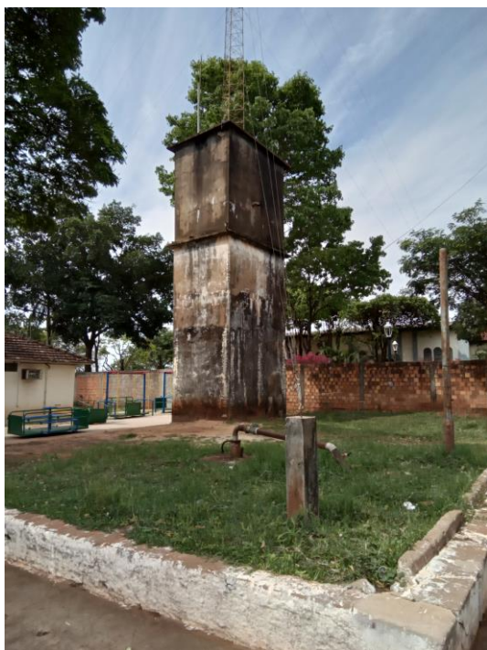
Foto 13 – Acesso ao Poço
