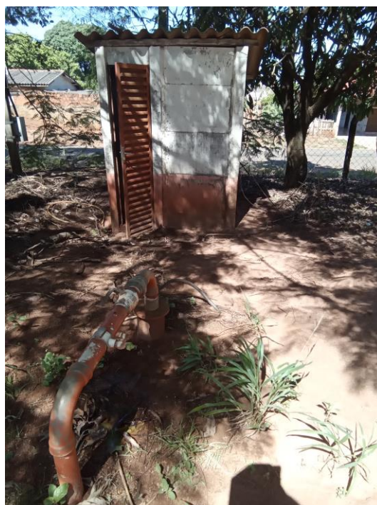
Foto 35 – Casa de comando
