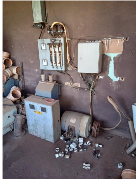
Foto 27 – Estrutura parte elétrica
