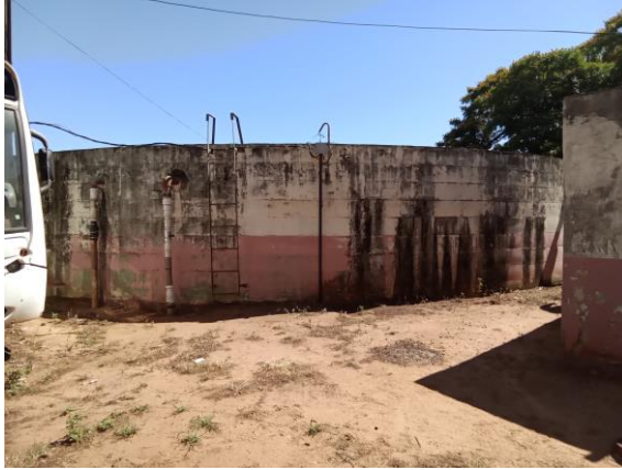
Foto 94 – Acesso ao reservatório
