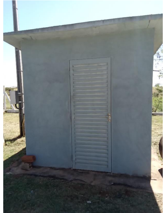
Foto 131 – Casa de comando
