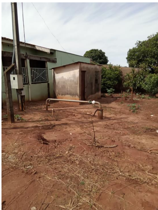
Foto 15 – Acesso ao Poço
