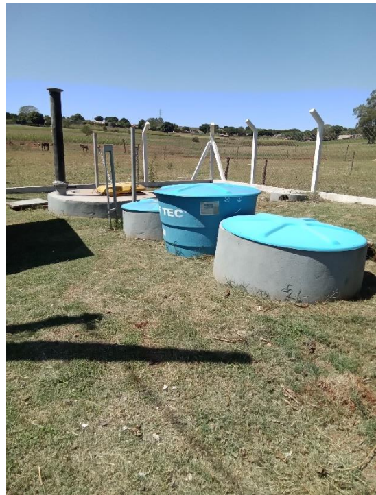
Foto 129 – Estrutura estação elevatória de esgoto
