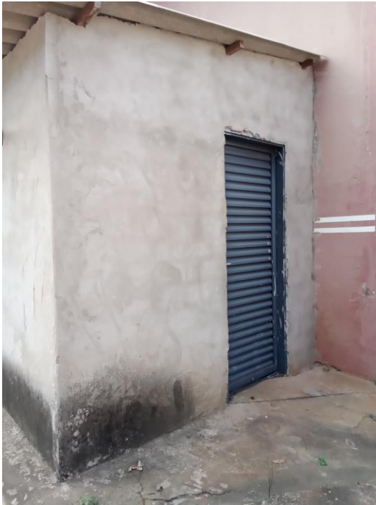
Foto 64 – Casa de comando
