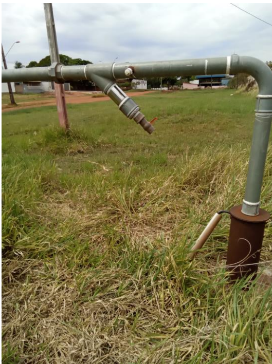
Foto 55 – Tomada de água bruta
