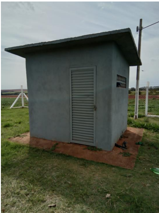
Foto 124 – Casa de comando
