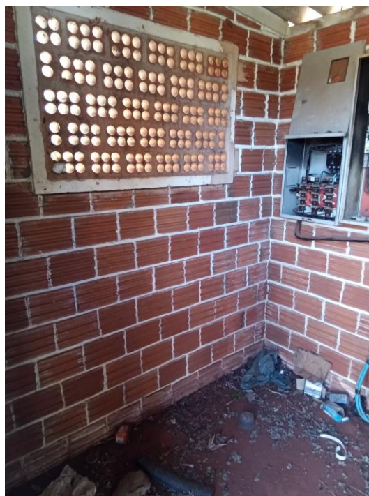
Foto 49 – Condições casa de comando/ entrada de ar
