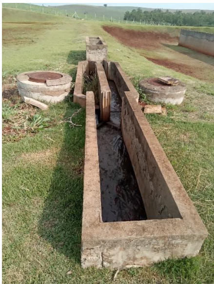
Foto 92 – Calha Parshall (entrada)
