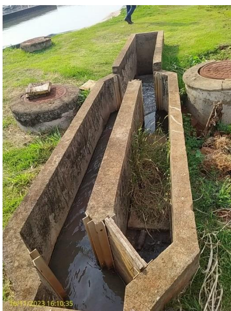
Foto 92 – Calha Parshall (entrada)
