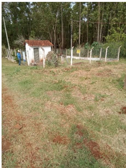
Foto 11 – Área de captação
