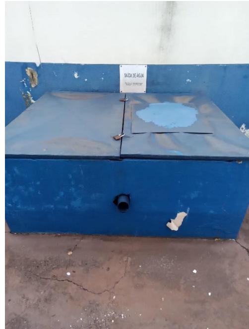
Foto 49 – Saída de água tratada
