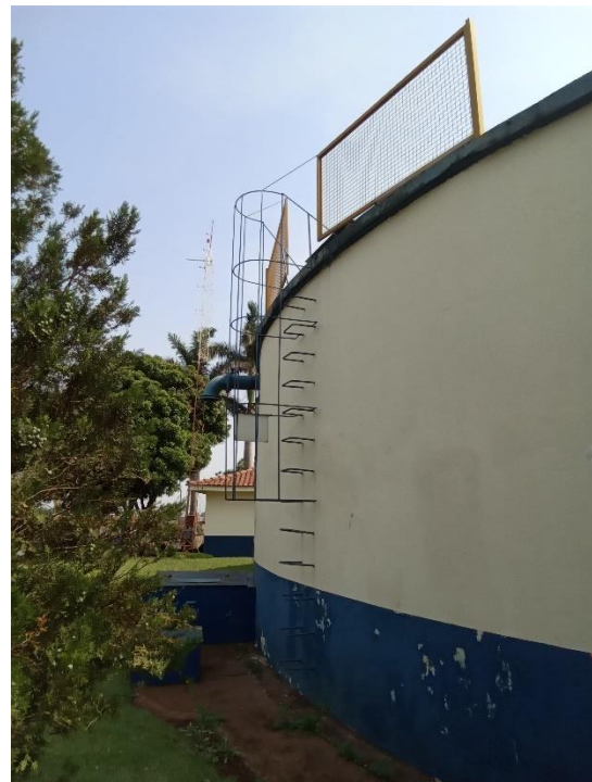
Foto 47 – Reservatório apoiado com guarda corpo
