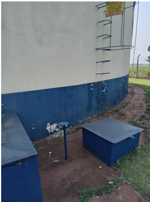
Foto 46 – Caixa de inspeção
