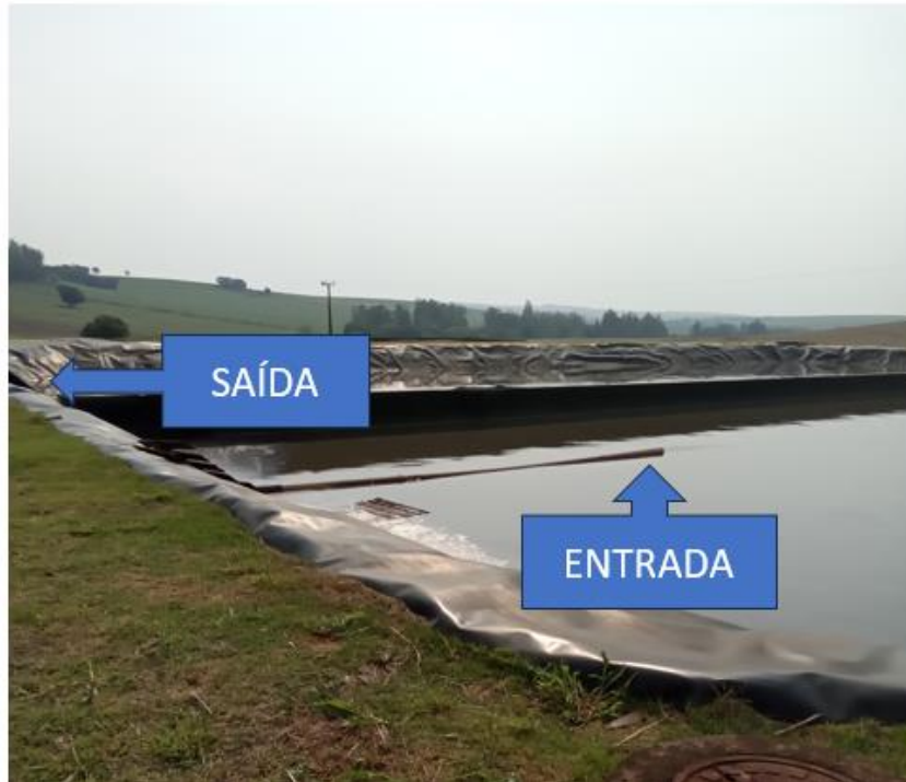
Foto 94 – Lagoa 1 e 2 anaeróbias (entrada)
