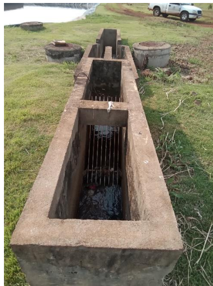
Foto 92 – Calha Parshall (entrada)
