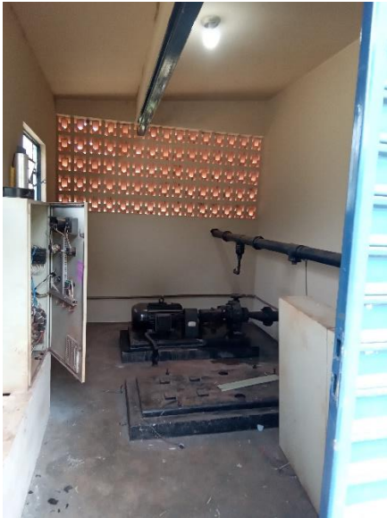
Foto 38 – Área da EEA
