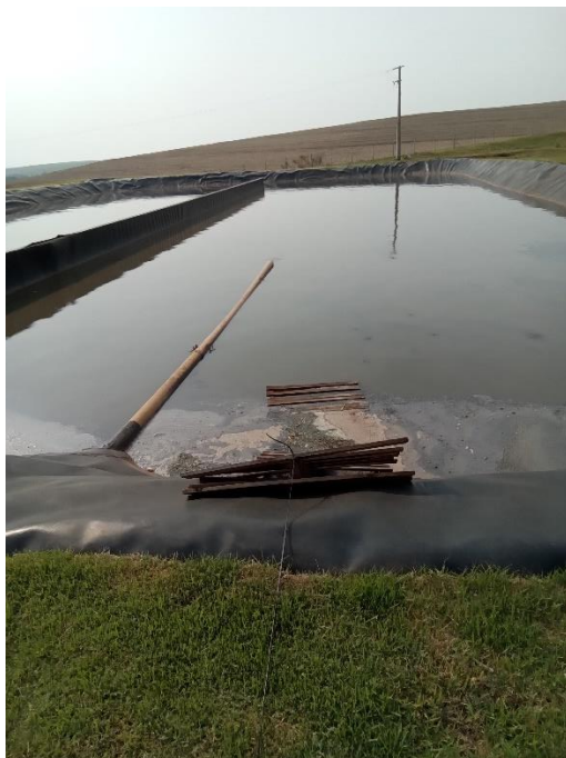
Foto 94 – Lagoa 1 e 2 anaeróbias (entrada)
