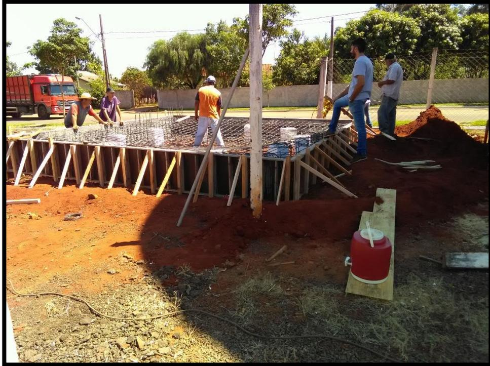
Imagem 8: Novo Reservatório Apoiado em Construção
