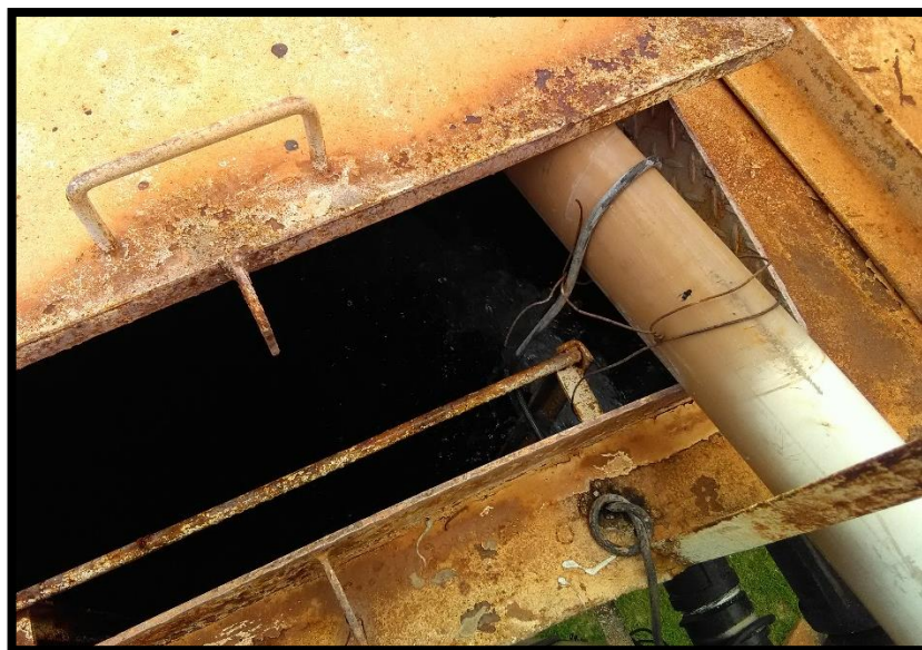
Imagem 17: Abertura de inspeção do reservatório de 400m 3
