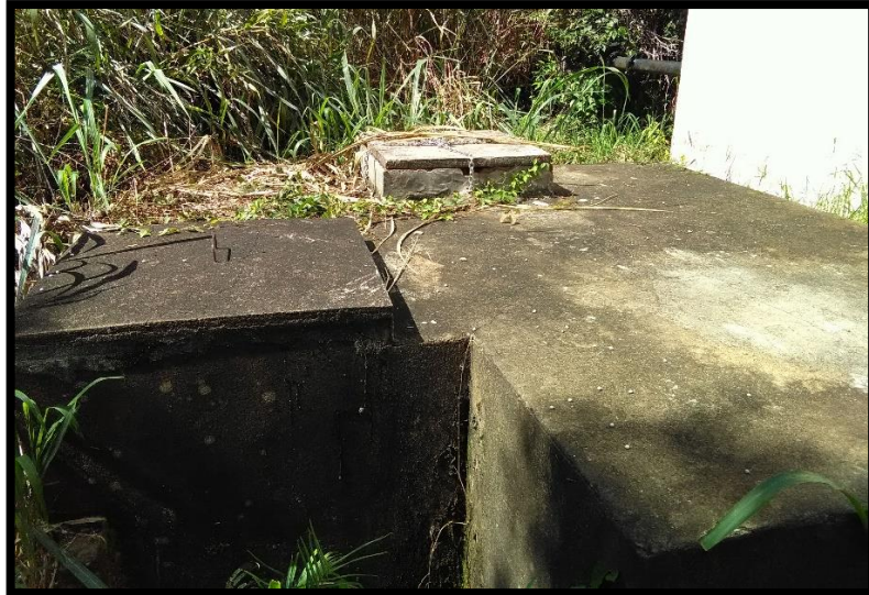
Imagem 15: Reservatório semienterrado da mina
