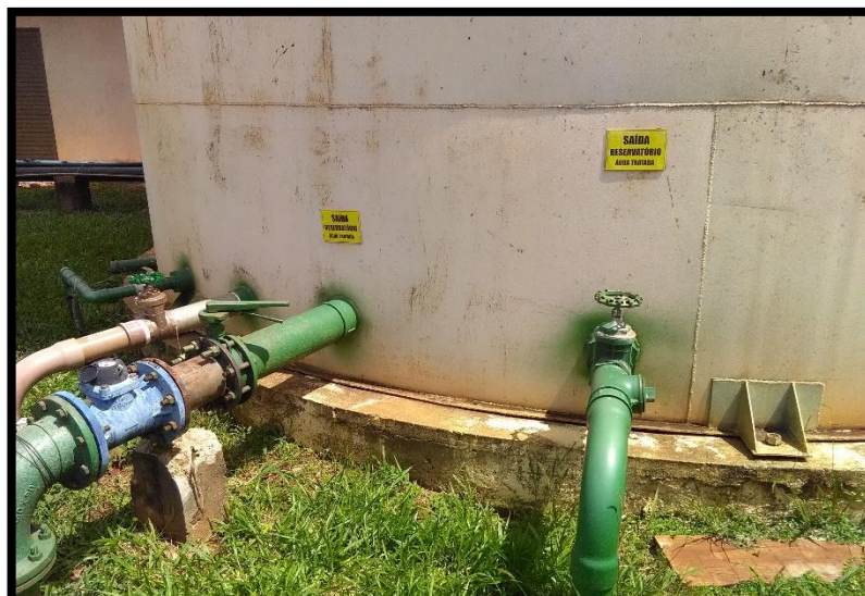
Imagem 16: Instalação hidráulica do reservatório apoiado de 400 m 3
