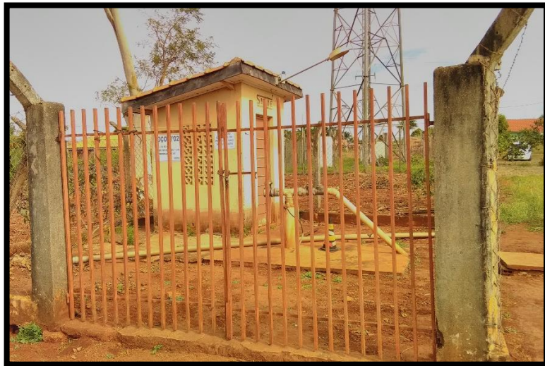
Imagem 3: Perímetro do poço 02
