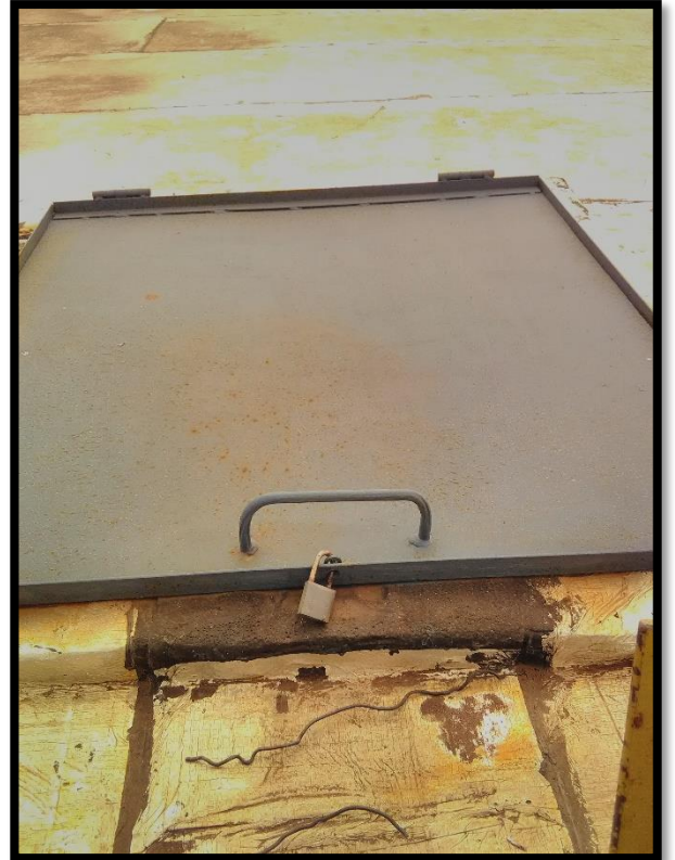
Imagem 8: Abertura de inspeção do reservatório apoiado
