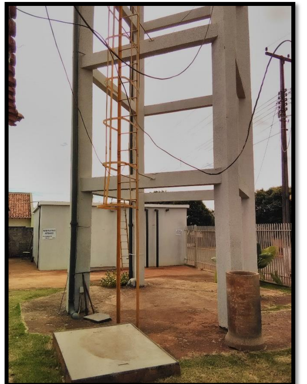
Imagem 10: Escada de acesso do reservatório elevado
