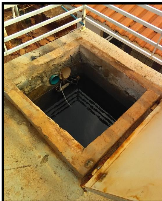
Imagem 9: Abertura de inspeção do RSE 2
