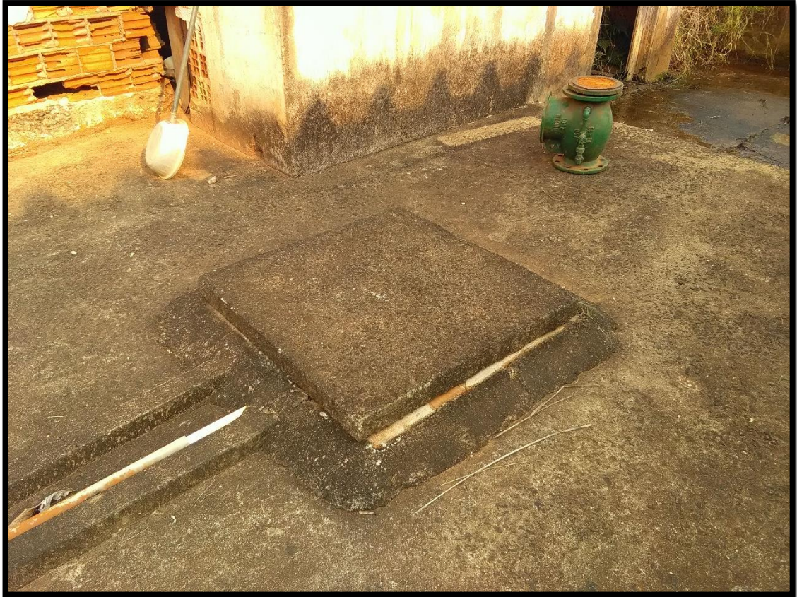
Imagem 5: Reservatório de acúmulo da mina
