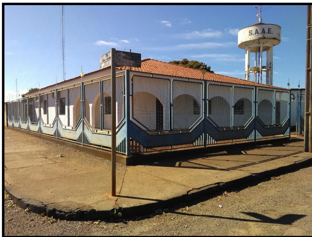
Imagem 1: Fachada da área comercial
