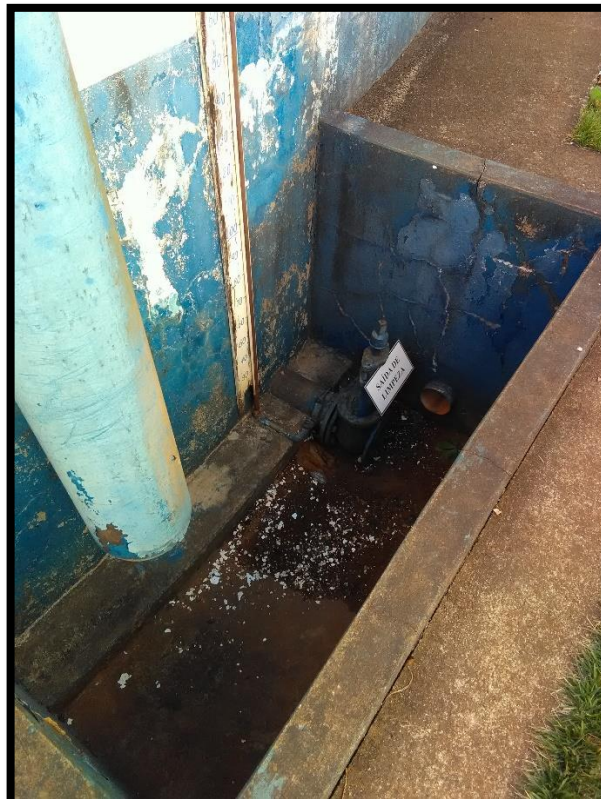
Imagem 11: Tubo de limpeza, tubo extravasor e nível do RSE
