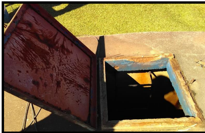
Imagem 10: Abertura de inspeção do reservatório semienterrado
