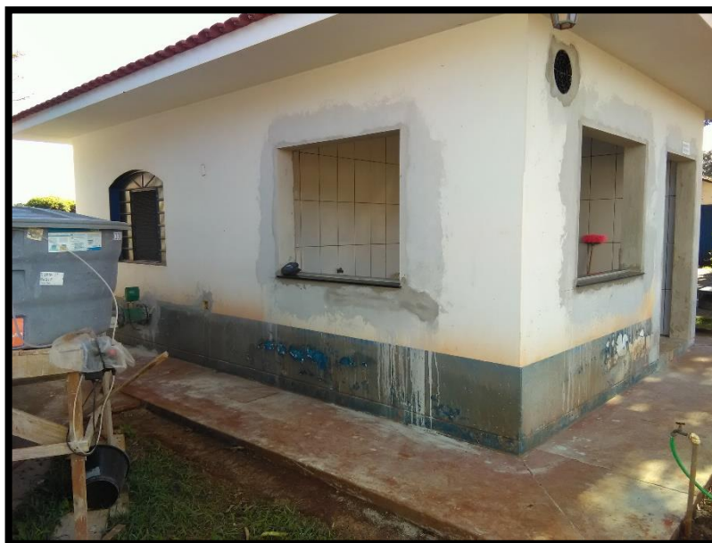
Imagem 7: Estação de tratamento simplificado em reforma
