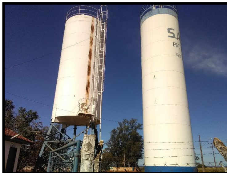
Imagem 17: Reservatórios do Sistema 2
