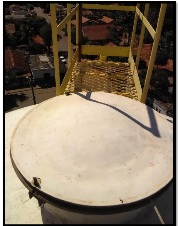
Imagem 14: Abertura de inspeção do Reservatório elevado
