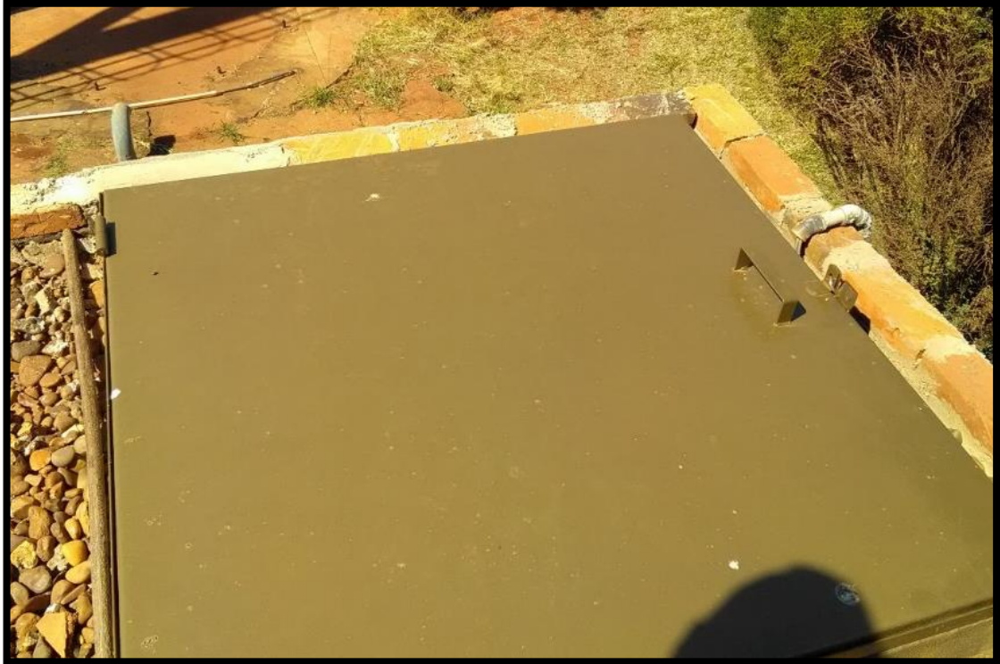
Imagem 12: Abertura de inspeção do reservatório apoiado
