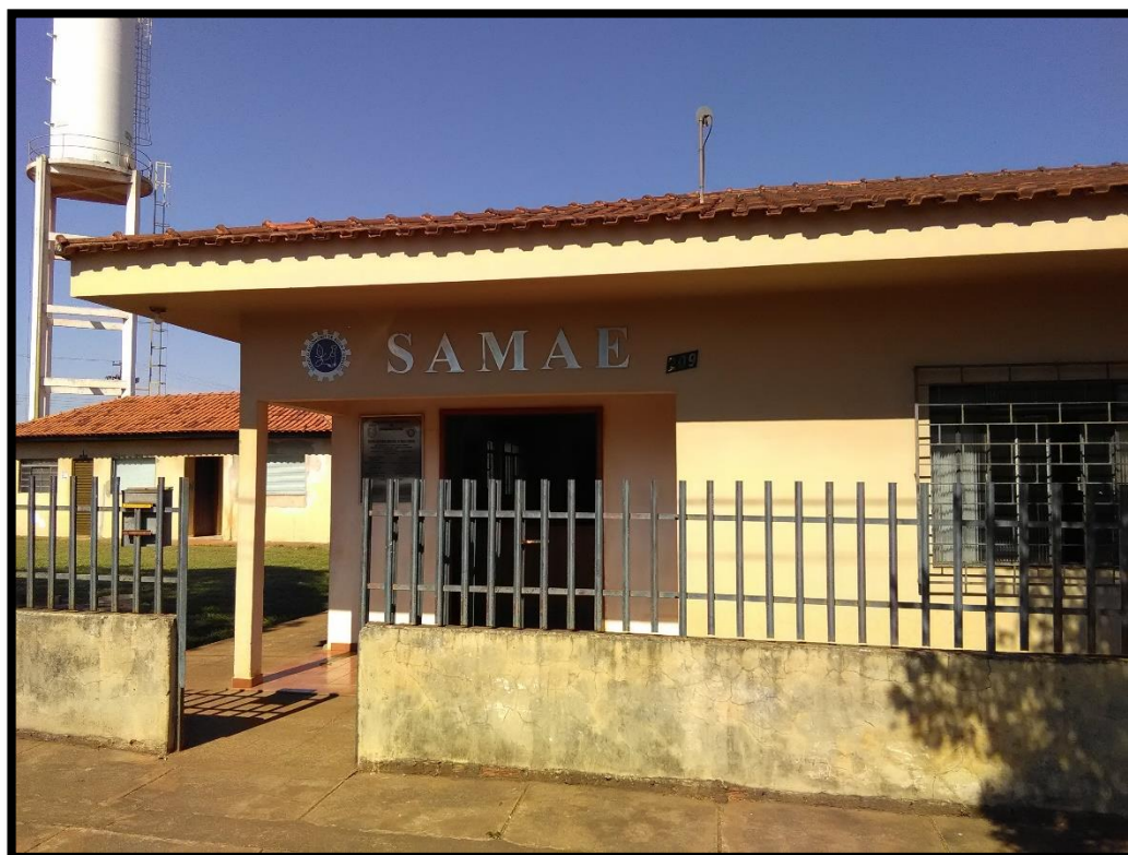
Imagem 1: Fachada da área comercial
