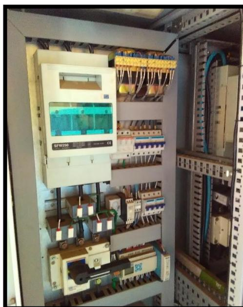
Imagem 43: Elevatória de esgoto – quadro de comando
