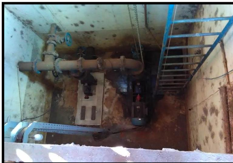
Imagem 42: Elevatória de esgoto – conjunto moto-bombas
