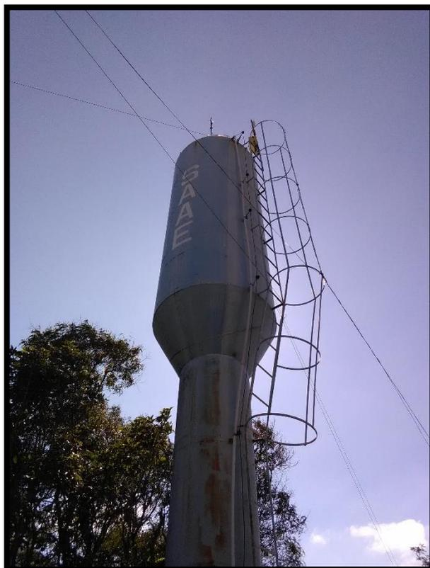
Imagem 28: RAP (não incluído na esquematização) – escada com gaiola de proteção
