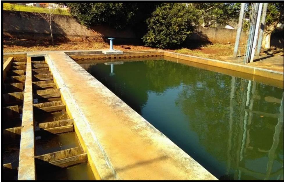
Imagem 12: Estação de tratamento Convencional – Chicanas do floculador e tanque decantador
