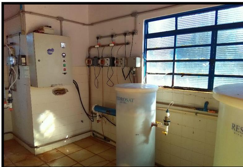
Imagem 14: Estação de tratamento do convencional – bombas dosadoras e reservatórios
