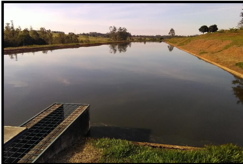
Imagem 34: Estação de Tratamento de Esgoto – Lagoa Facultativa
