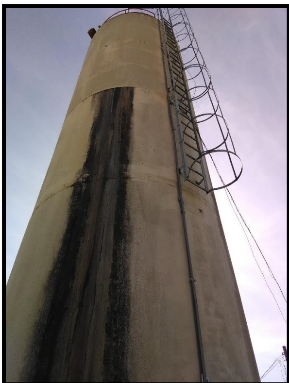
Imagem 17: Reservatório elevado de apoio – REL
