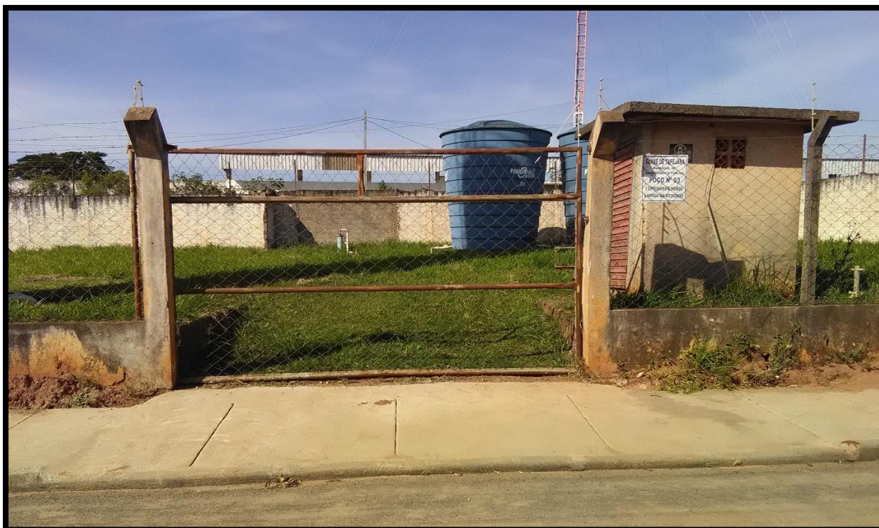
Imagem 16: Reservatórios apoiados de apoio – RAP
