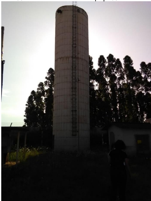
Foto 39 – Reservatório elevado poço 05
