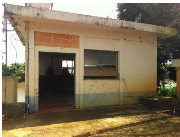
Foto 05 – Casa de bombas da captação de água superficial
