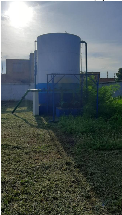
Foto 41 – Reservatório elevado poço Bela Vista
