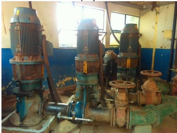
Foto 44 – Elevatória captação Rio das Cinzas
