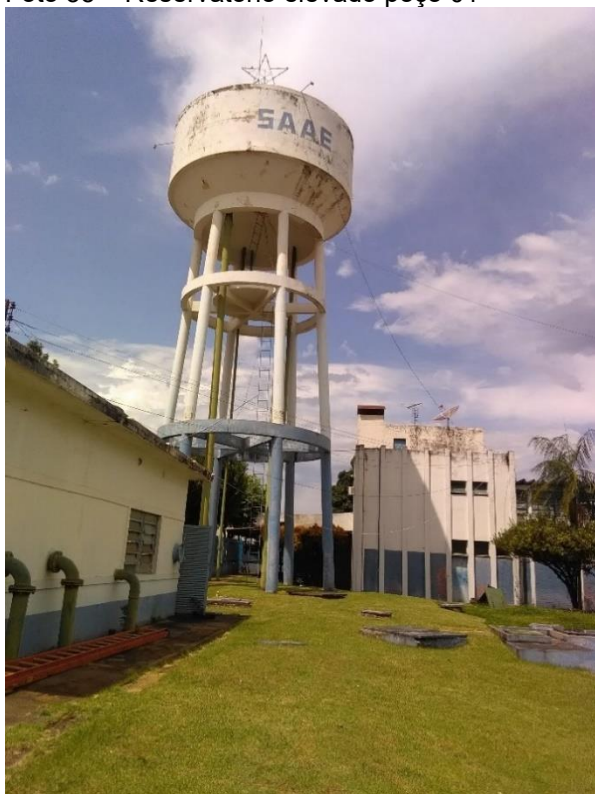
Foto 35 – Reservatório elevado poço 01
