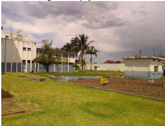
Foto 10 – vista geral local poço 01
