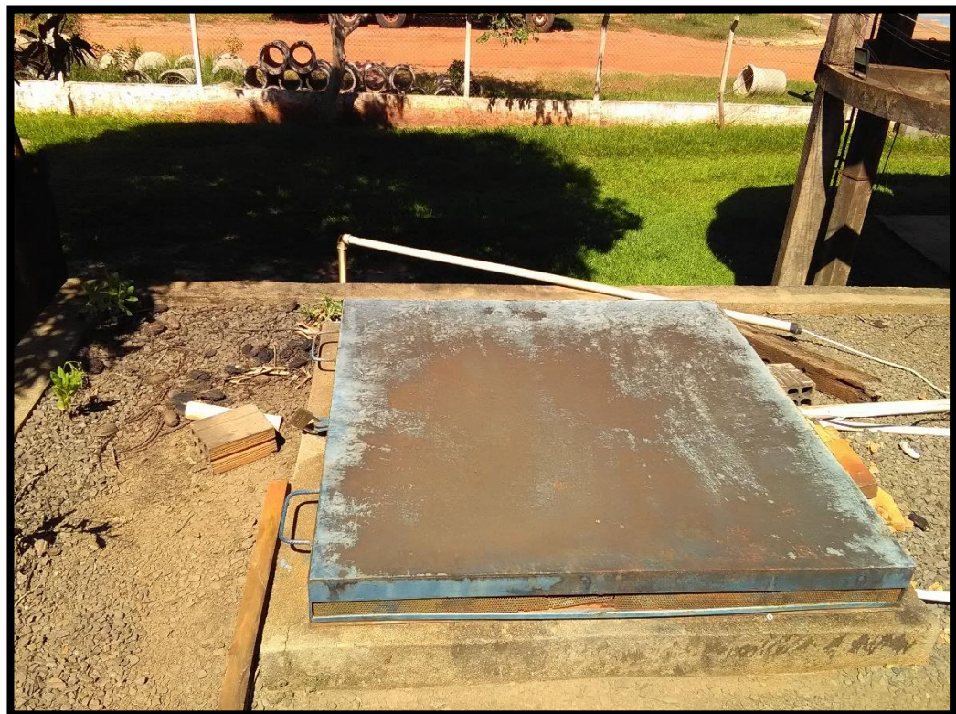
Imagem 12: Abertura de inspeção do Reservatório apoiado do distrito
