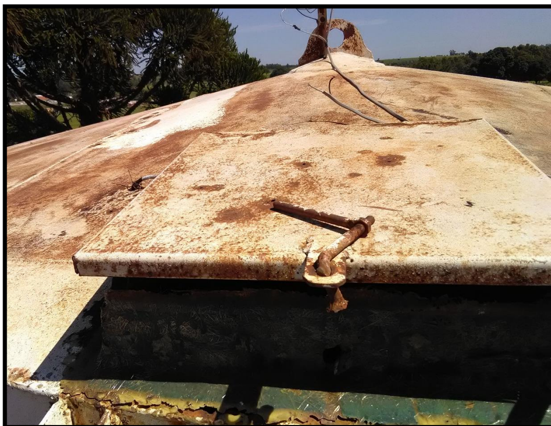
Imagem 10: Abertura de inspeção do Reservatório elevado do Sistema Sede
