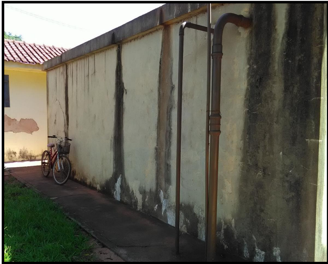
Imagem 11: Reservatório apoiado do distrito
