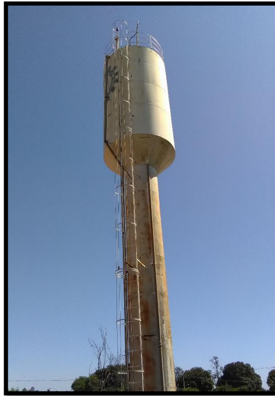
Imagem 13: Reservatório elevado do Sistema Sede
