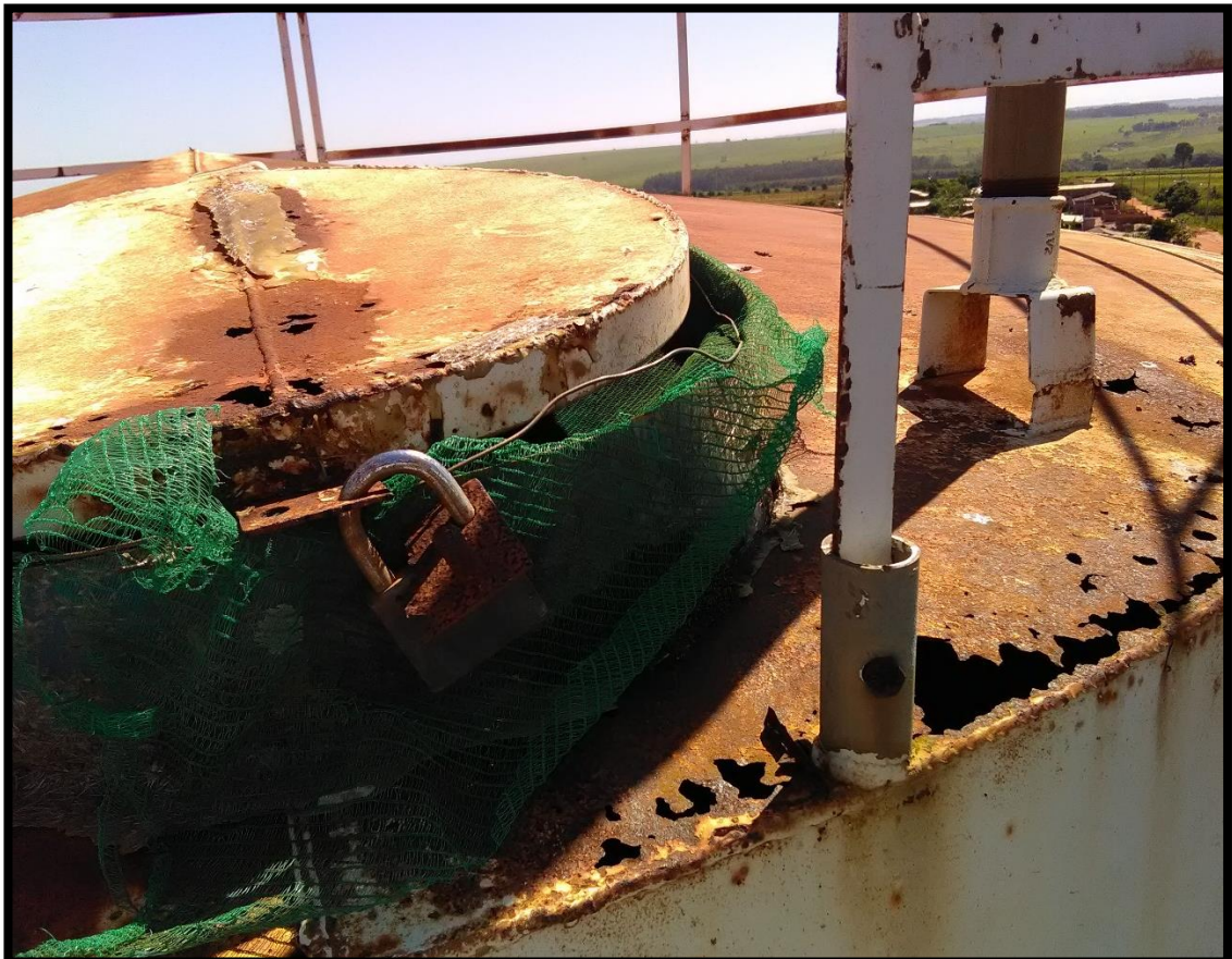
Imagem 14: Abertura de inspeção do Reservatório elevado do Sistema Sede
