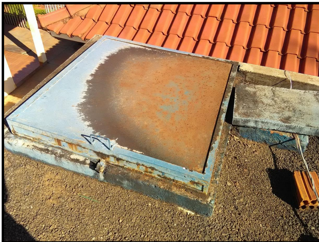
Imagem 8: Abertura de inspeção do Reservatório apoiado
