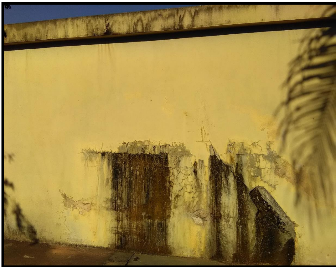
Imagem 7: Reservatório apoiado do sistema Sede
