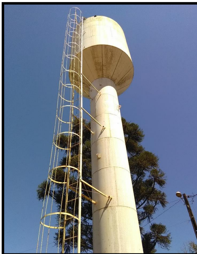
Imagem 9: Reservatório elevado do Sistema Sede
