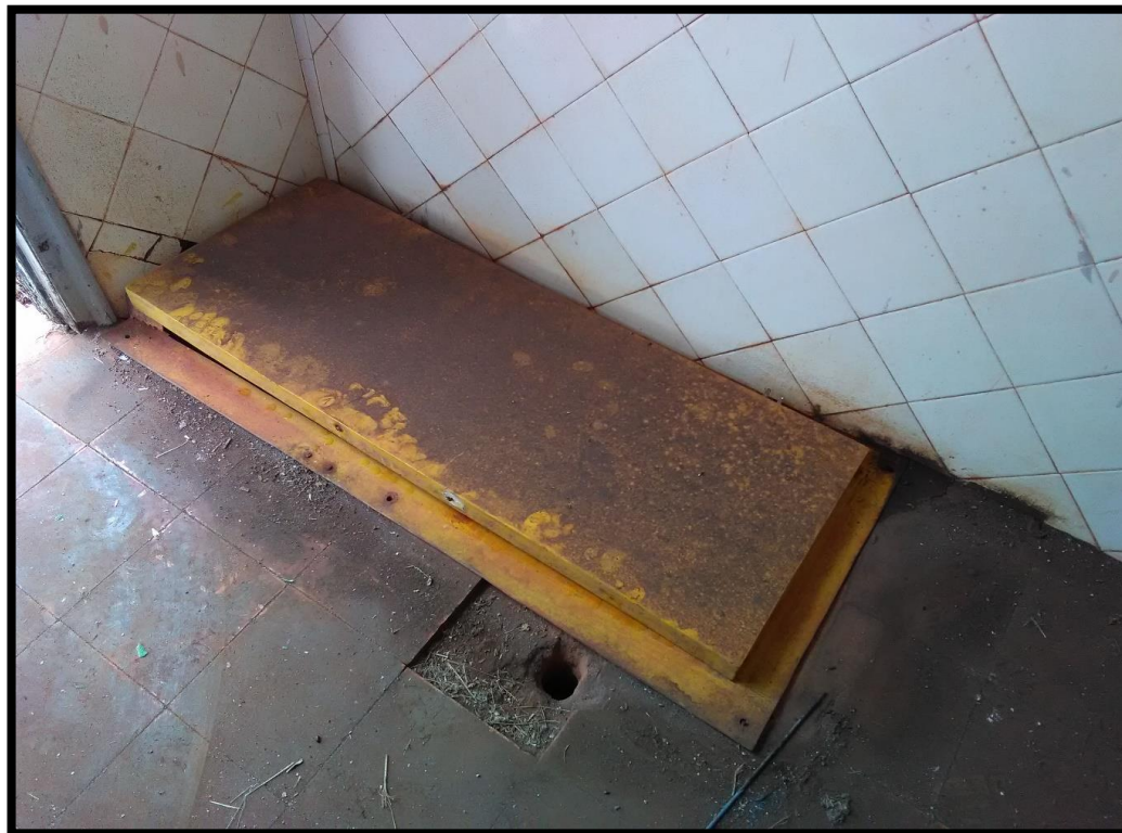
Imagem 20: Abertura de Inspeção do Reservatório Enterrado (REN 2)
