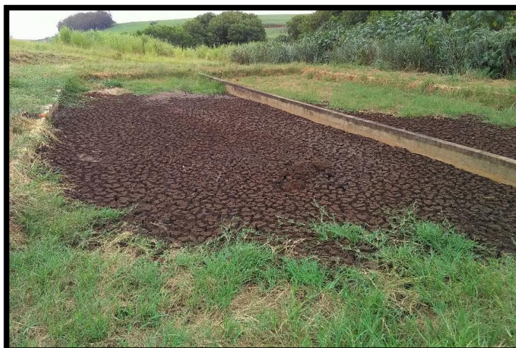
Imagem 47: Leito de Secagem de Lodo – ETE das Antas
