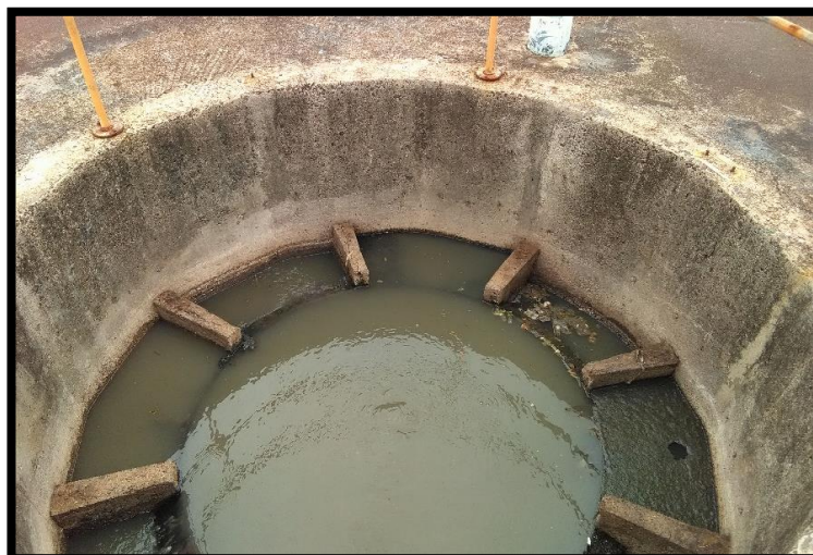
Imagem 46: Reator Anaeróbio – ETE das Antas
