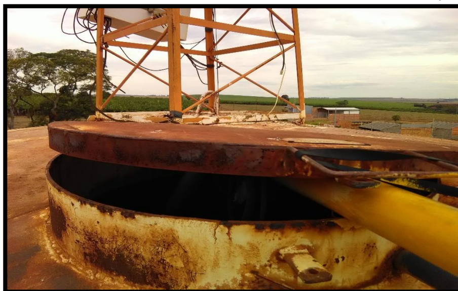
Imagem 24: Abertura de Inspeção do Reservatório elevado do distrito Nossa Senhora aparecida
