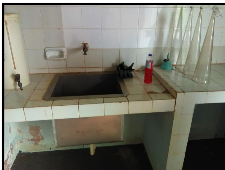
Imagem 48: Edificação de apoio – ETE Barrerão
