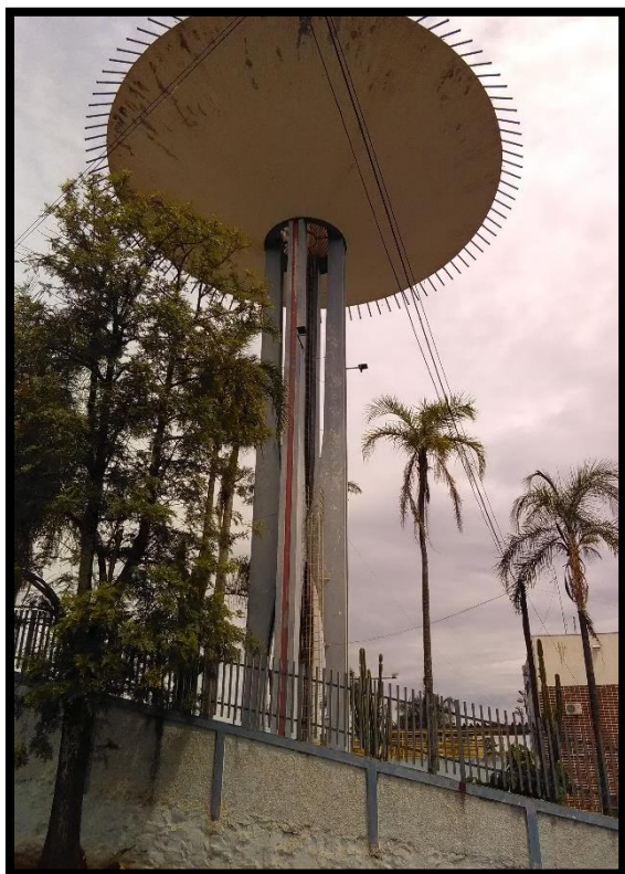
Imagem 22: Reservatório elevado (REL 1)
