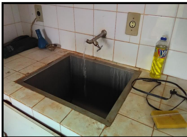
Imagem 42: Edificação de apoio – ETE Barrerão
