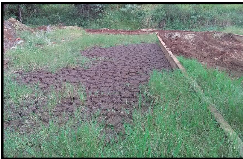
Imagem 41: Leito de Secagem de Lodo – ETE Barrerão
