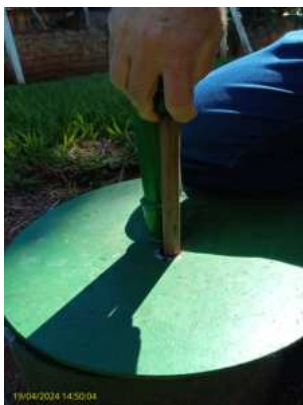
Foto 1 - Medidor de nível
