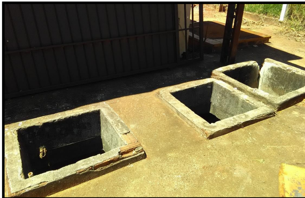
Imagem 21: Estação elevatória de esgoto 1 – aberturas de inspeção do reservatório de recalque
