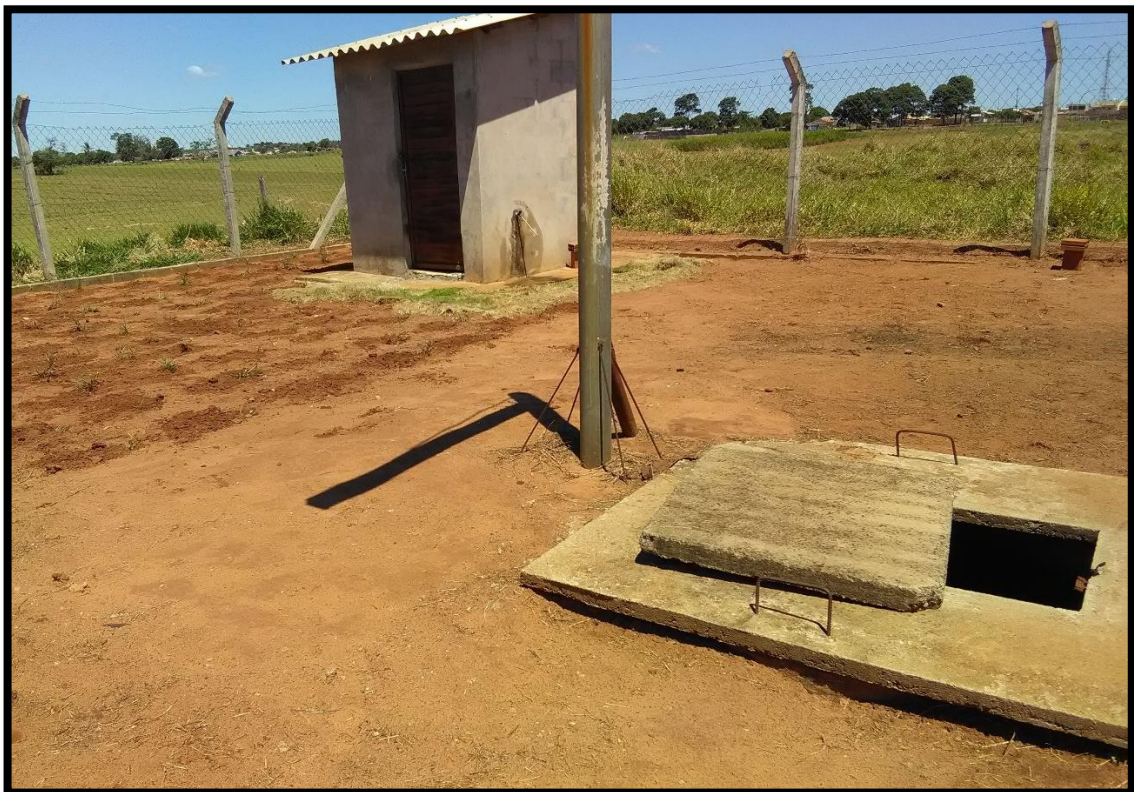
Imagem 25: Estação elevatória de esgoto 3 – aberturas de inspeção do poço de recalque
