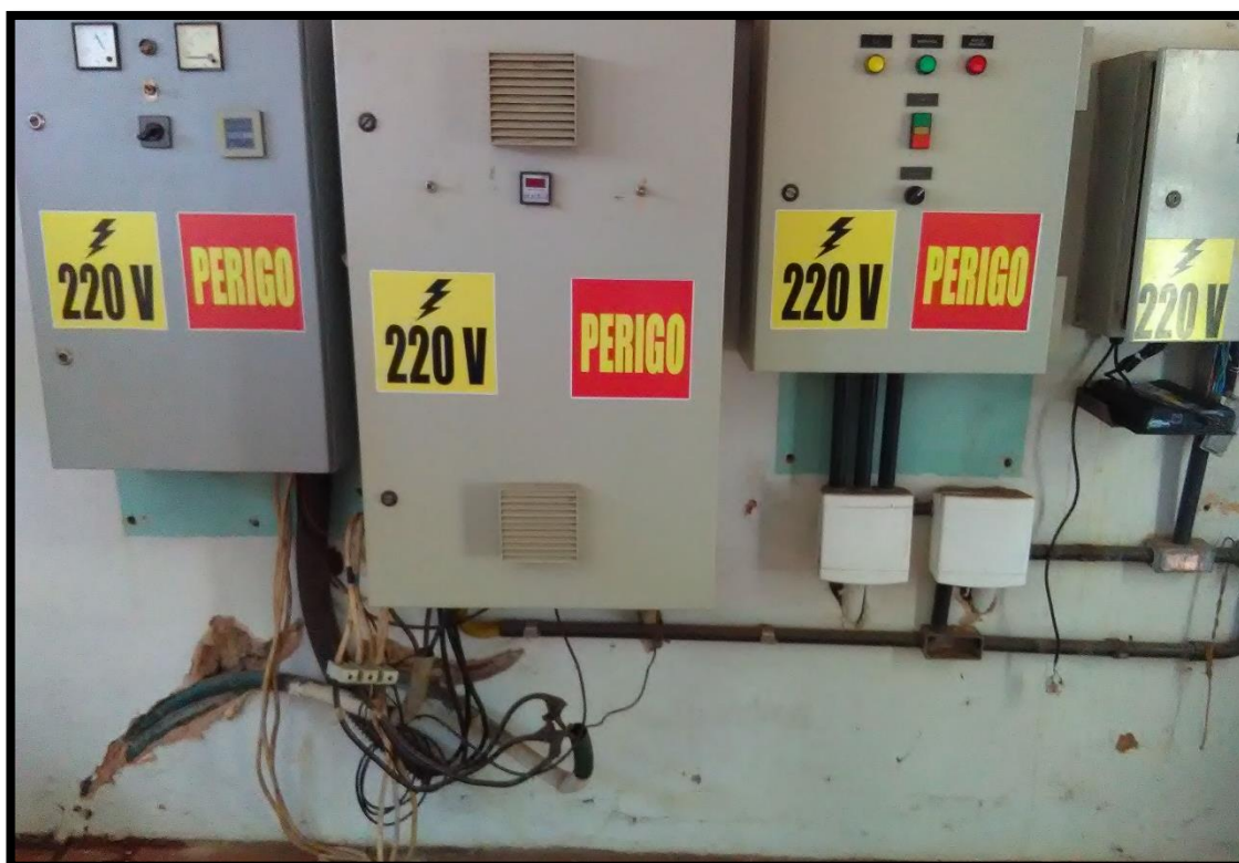
Imagem 12: conjunto moto bomba da Estação elevatória que abastece o REL Central
