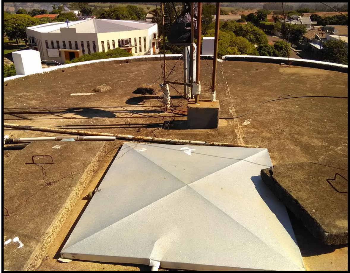
Imagem 8: Reservatório Elevado Central
