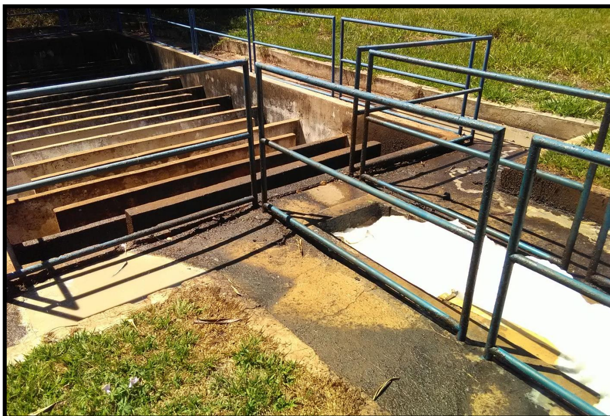
Imagem 31: Calha parshal de saída e chicanas
