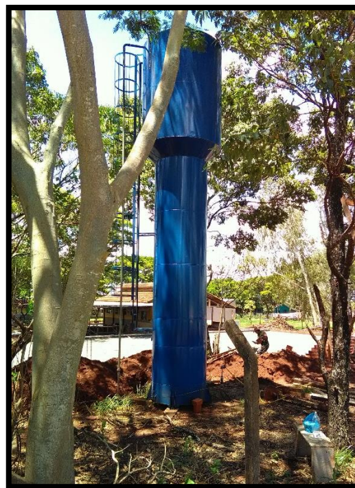
Imagem 11: reservatório elevado do distrito
