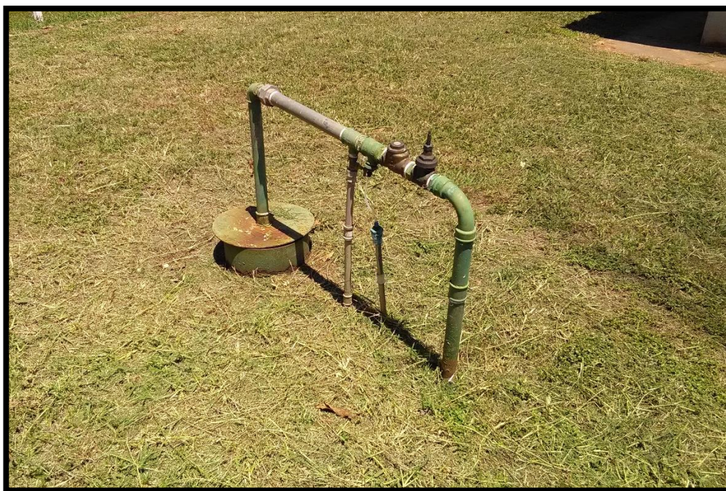
Imagem 5: poço do distrito
