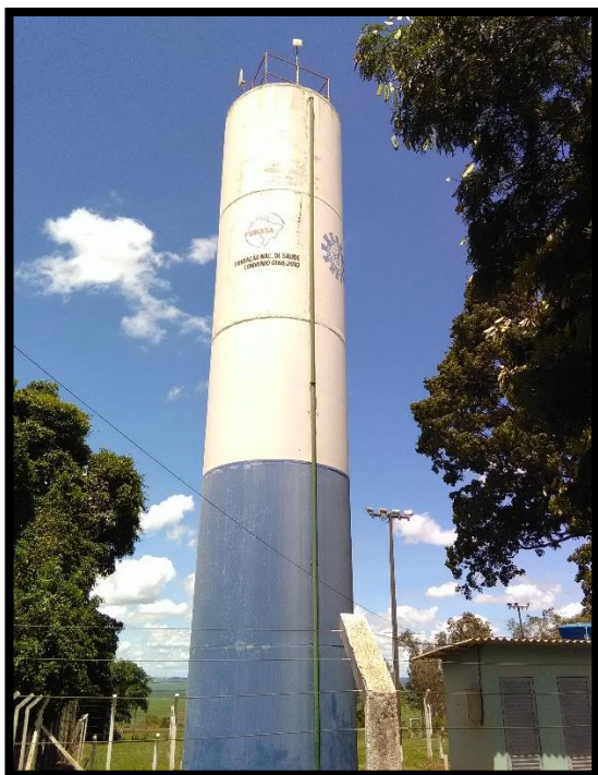
Imagem 10: reservatório elevado do distrito
