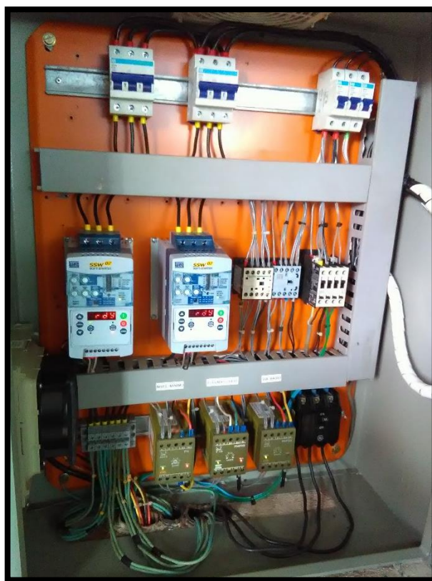
Imagem 15: quadro de comando da Estação Elevatória de água
