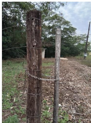
Foto 37 a – Entrada poço 1
