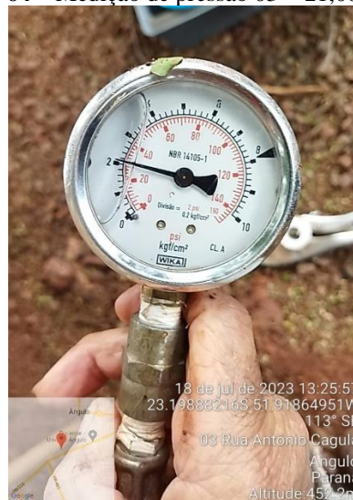
Foto 64 – Medição de pressão 03 = 21,00 m.c.a
