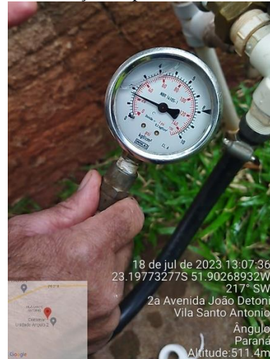
Foto 58 – Medição de pressão 01 = 17,50 m.c.a
