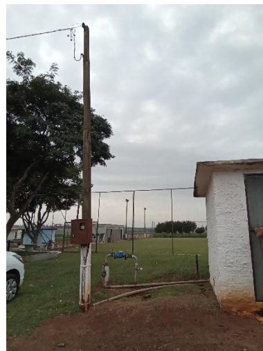
Foto 41 – Poço Valência e abrigo quadro de energia
