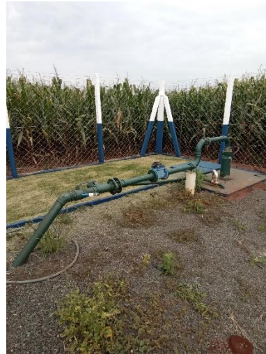
Foto 48 – Instalações novo poço
