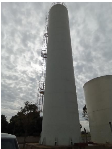
Foto 53 – Reservatório central novo
