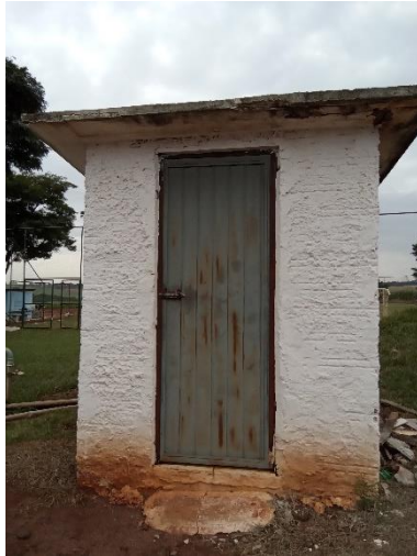
Foto 44 – Quadro de energia
