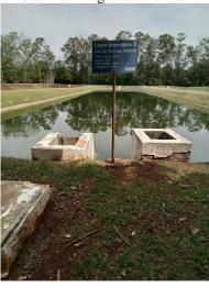
**Foto 122** – Gradeamento e cacha parshall entrada do esgoto
