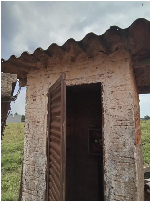
Foto 18 – Casa de comando
