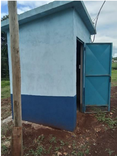
Foto 33 – Casa de comando
