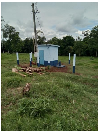
Foto 31 – Acesso poço Forquilha
