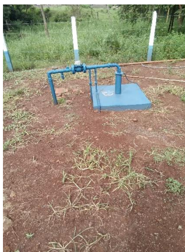
Foto 75 – Poço Arroio Guaçu
