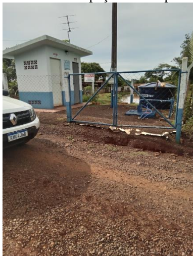
Foto 54 – Acesso poço Nova Esperança
