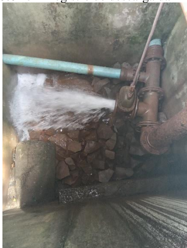
Foto 25 – Registro de descarga da mina
