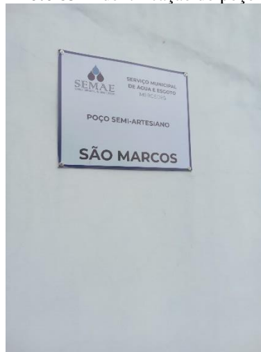
Foto 83 – Identificação do poço
