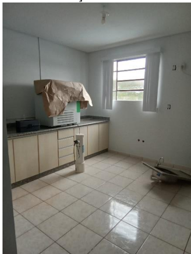
Foto 159 – Laboratório físico químico em fase de finalização de reforma
