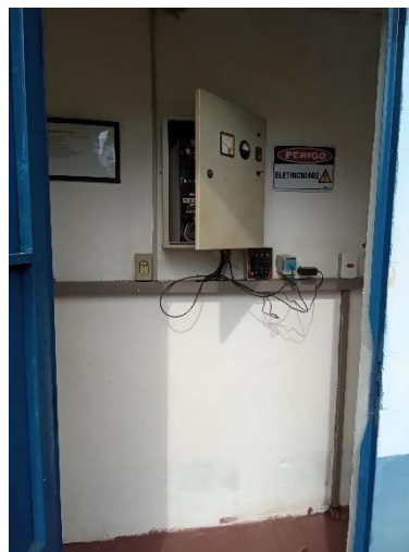
Foto 77 – Acesso casa de comando
