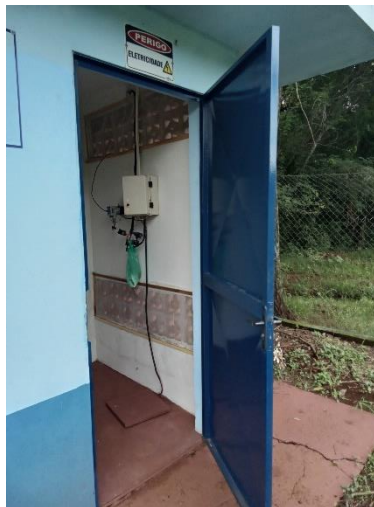
Foto 42 – Acesso casa de comando
