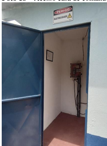
Foto 18 – Acesso casa de comando
