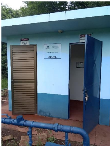
Foto 41 – Casa de comando
