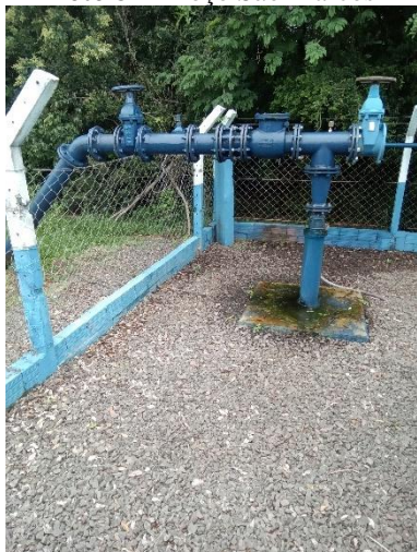
Foto 82 – Poço São Marcos
