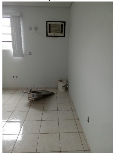
Foto 160 - Laboratório físico químico em fase de finalização de reforma
