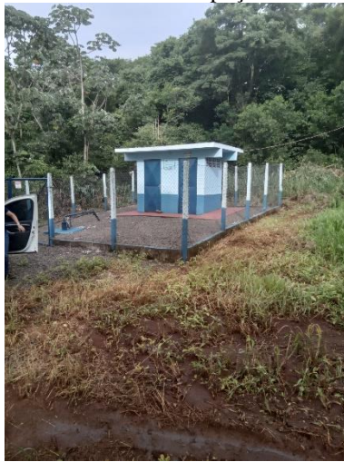
Foto 47 – Acesso poço Gleba
