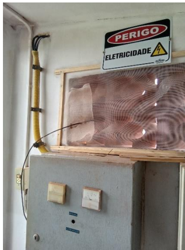
Foto 69 – Entrada de ar casa de comando
