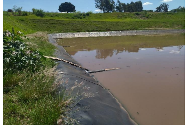
Foto 96: Saída lagoa anaeróbia 1
