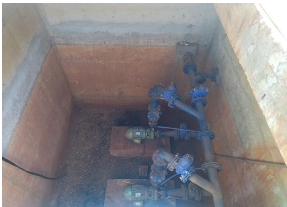
Foto 110: Abrigo das bombas
