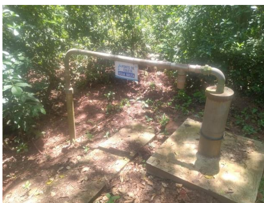
Foto 52: Condições estruturais do poço.
