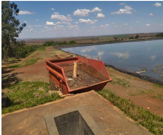
Foto 92: Armazenamento de resíduos
