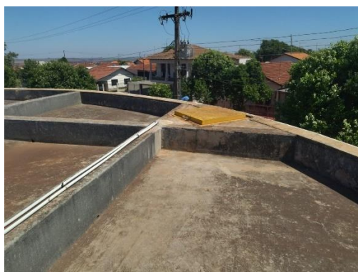
Foto 82: Tampa de inspeção.
