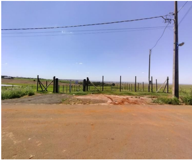
Foto 106: EE1 – Cercamento, acesso, identificação
