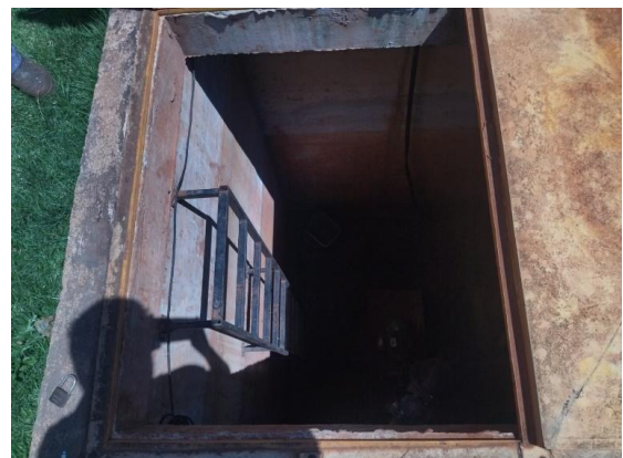
Foto 111: Escada de acesso ao abrigo
