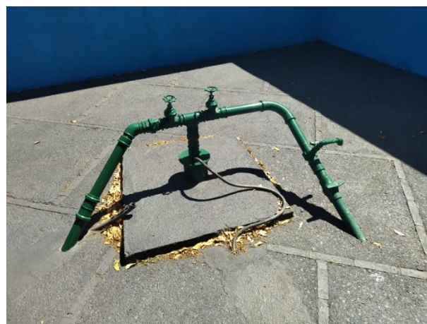
Foto 44: Estrutura do poço.
