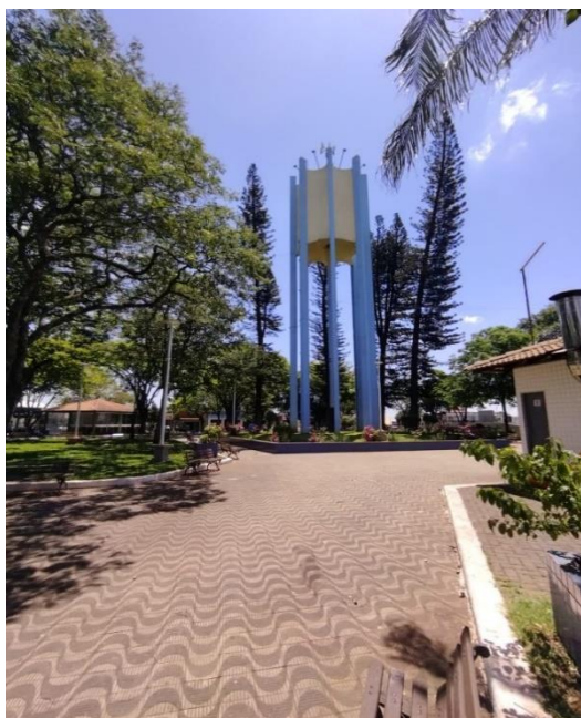
Foto 69: Localização Reservatório Praça Central
