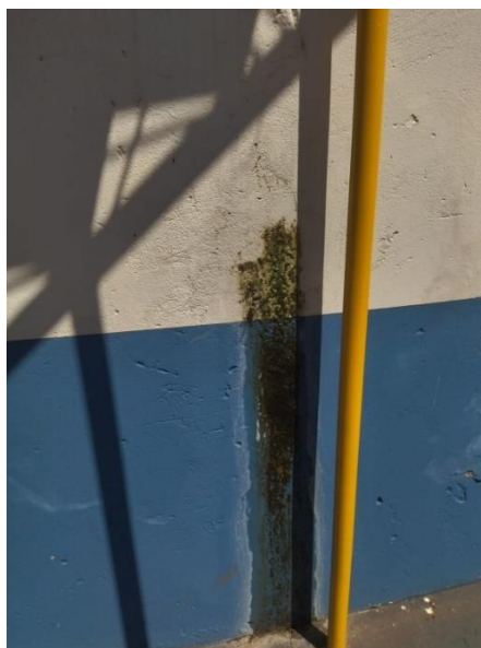
Foto 79: Vazamentos aparentes
