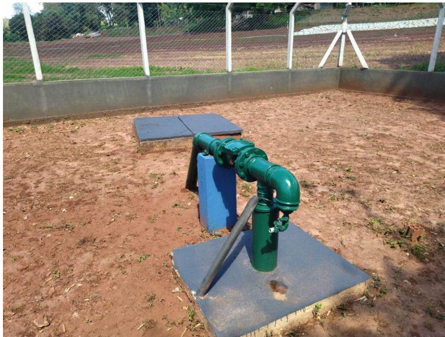
Foto 39: Instalações e estrutura do poço.
