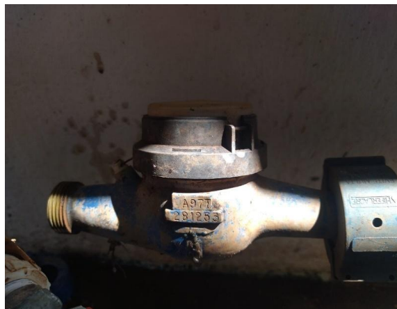
Foto 89: Ponto 3 – Ano de fabricação do hidrômetro.
