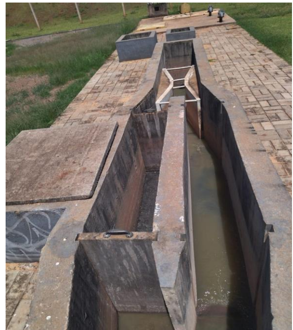
Foto 117: Desarenador (Primário)
