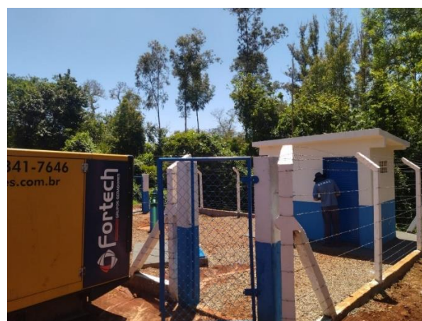
Foto 27: Local ainda não possui sinalização.
