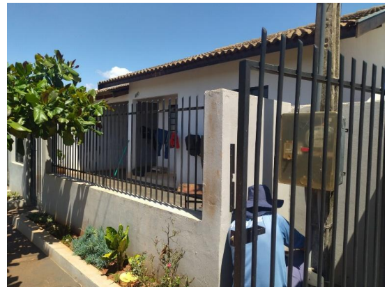
Foto 87: Ponto 2 – Medição de pressão (Rua da Esperança, 400)
