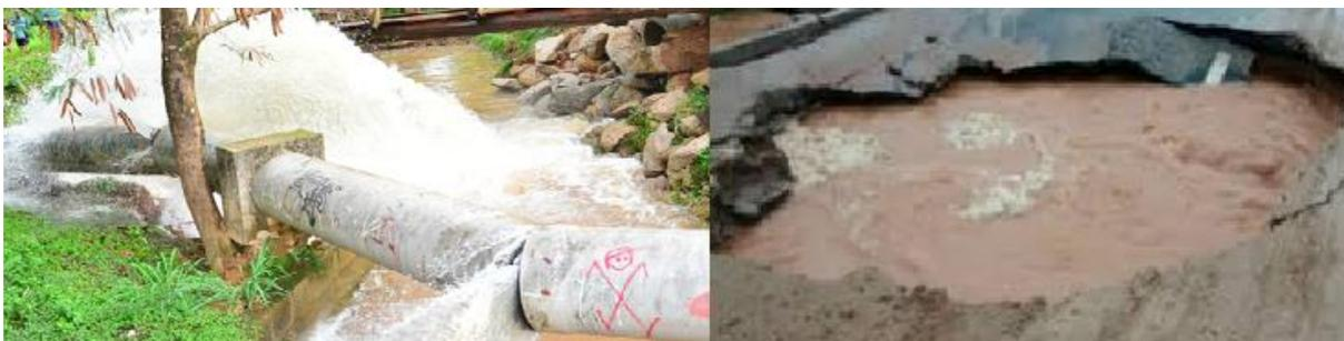
Figura 09 – Trecho de adutora rompida em travessia suspensa sobre curso d'água à esquerda e pavimento cedido após rompimento de adutora à direita.
