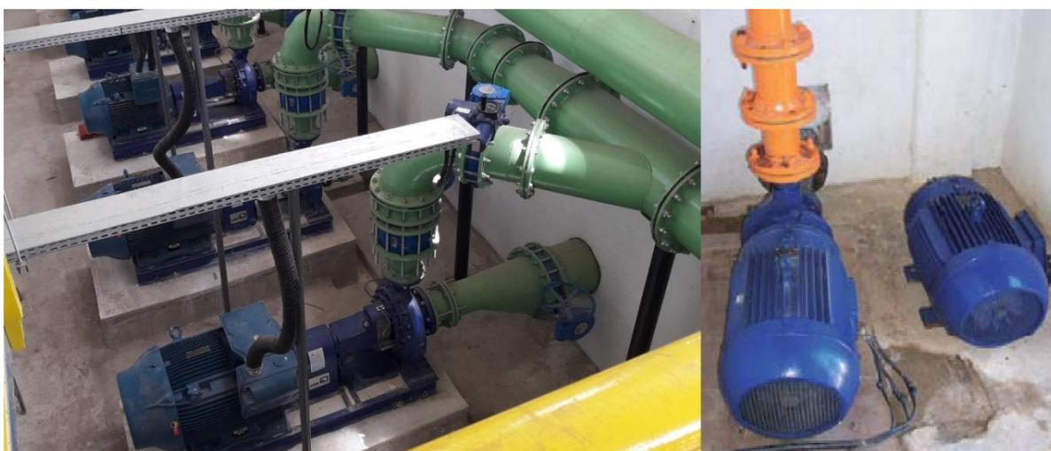
Figura 07 – Elevatórias de água com bomba reserva
