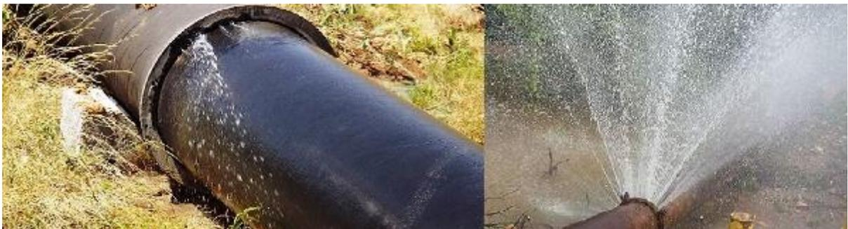
Figura 08 – Adutoras de água com vazamento
