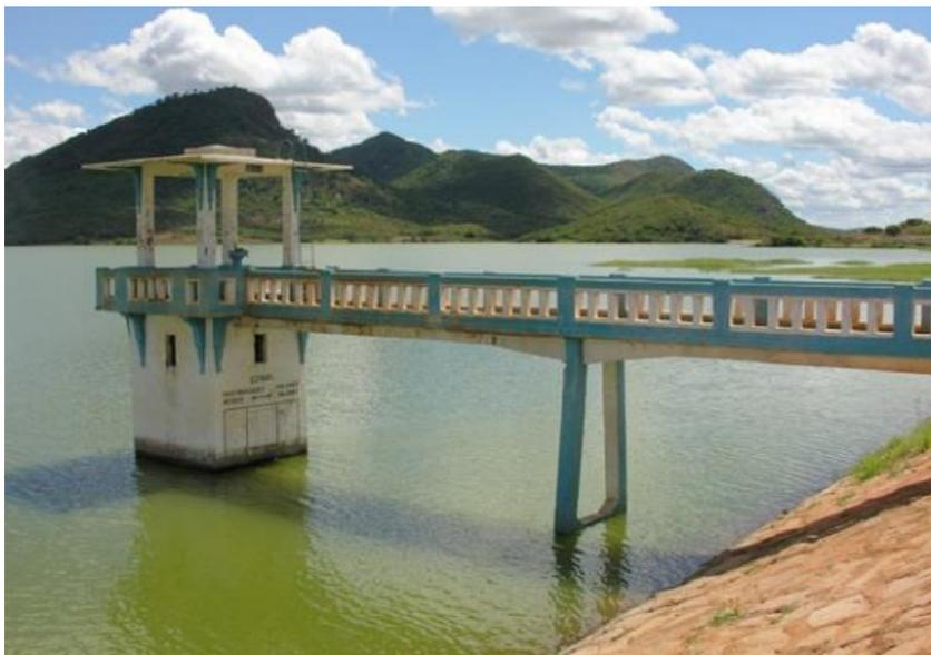
Figura 05 – Tomada de água em torre com acesso por passadiço.
