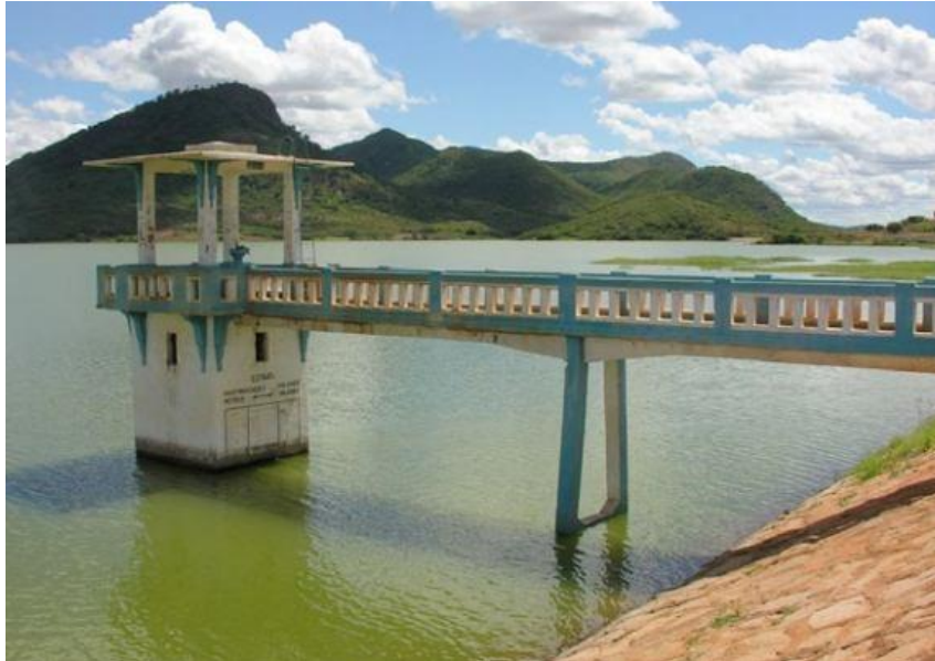
Figura 8 – Tomada de água em torre com acesso por passadiço.
