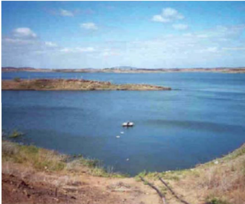
Figura 9 – Tomada de água flutuante sem passadiço (acesso necessita barco/bote).
